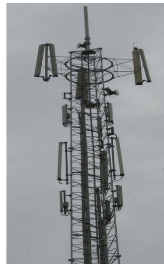
Het "digitale" asbest van Nu
