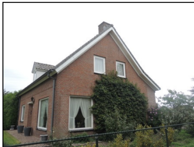
Figuur 4. Noordwestzijde woonhuis.
