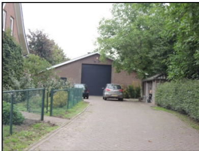
Figuur 6. Westzijde voormalige varkensstal met aan de rechterkant een kippenbinnenverblijf.
