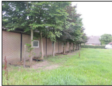
Figuur 10. Noordzijde voormalige varkensstal.
