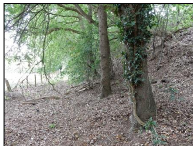
Figuur 10. Spoortalud t.h.v. Molenhoek
