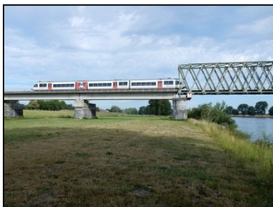
Figuur 9. Spoorbrug over de Maas.
