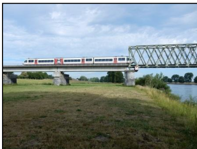
Figuur 9. Spoorbrug over de Maas.
