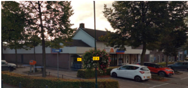
Foto bestaande situatie
