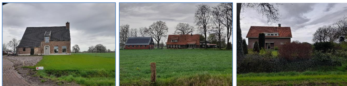
Figuur 8 Keursweg 2b, 3, Iemenkampsweg 1, Voorbroeksweg 4/4a,
