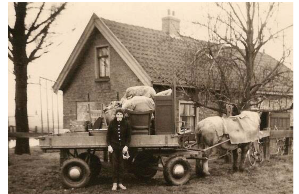
Opname van de woning bij de bovenmolen in 1983 vlak voor de sloop. De gevelkarakteristiek en massavorm van deze woning dient als uitgangspunt bij de reconstructie van de molenaarswoning
