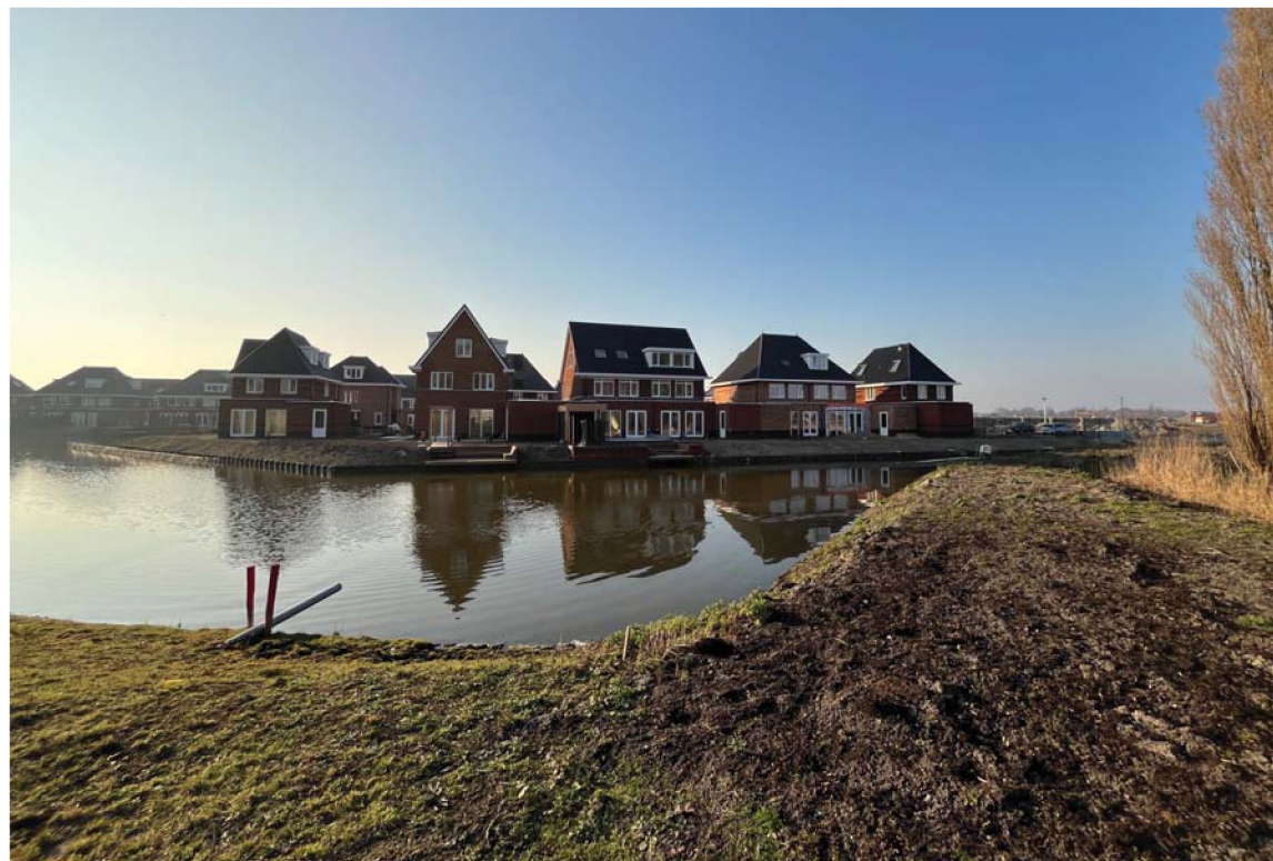
De achterzijde van de bebouwing langs de Carol van Herwijnenhoek
