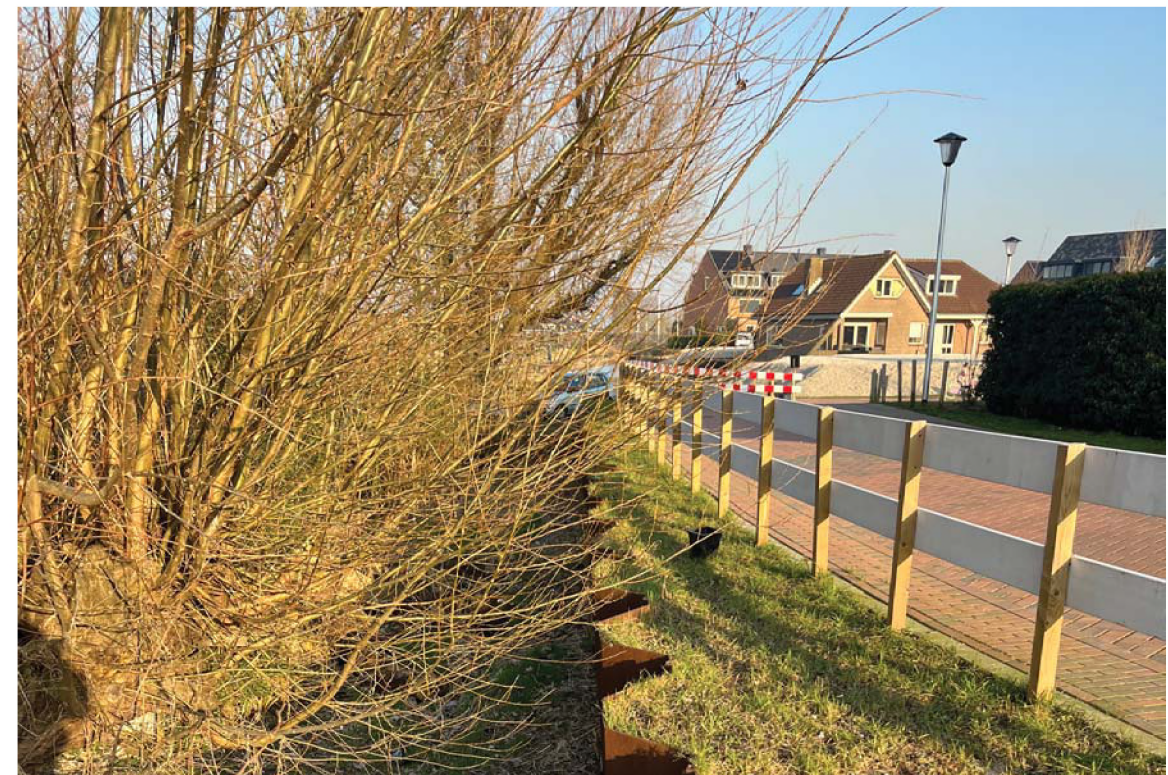
Damwand op de overgang van het kleiplateau aan de noordzijde bij de Lies Frankenweg
