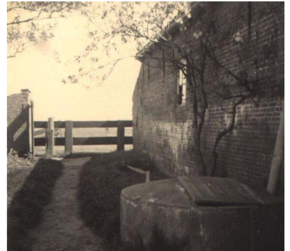
Beeld aan de achterzijde van het huis bij de Bovenmolen in de Westpolder. De gevel vertoont gelijkenissen bij de woning aan de Lies Frankenweg. Echter is de gevel hoger opgemetseld. Mogelijk is de gevel van het achterste deel van de woning aan de Lies Frankenweg eveneens hoger geweest.
