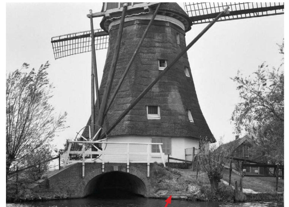
Vergelijkbare situatie bij molen De Valk van de overkluiste waterloop
