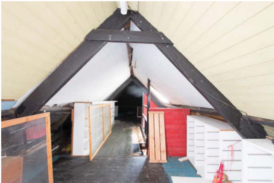
Beeld van het interieur van de zolderverdieping van de molenaarswoning.
