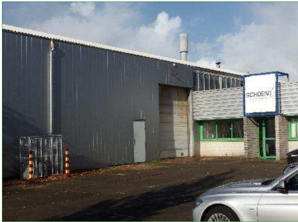
Een gedeelte van de loods aan de zuidzijde van het plangebied.
