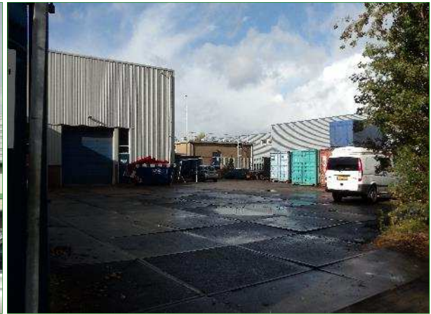
Het binnenplein aan de noordoostzijde van het plangebied
