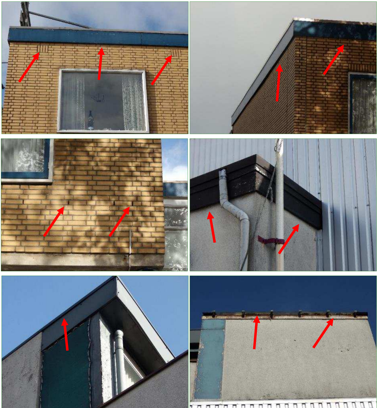
Diverse locaties op de bebouwing die mogelijk toegang geven tot voor vleermuizen geschikte achterliggende ruimtes (aangegeven met een rode pijl).
