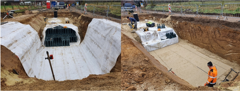
Figuur 6 aanleg infiltratievoorziening Holleweg Schinnen
