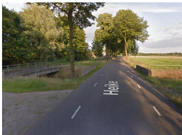
Figuur 1.2: Bovenzijde brug
