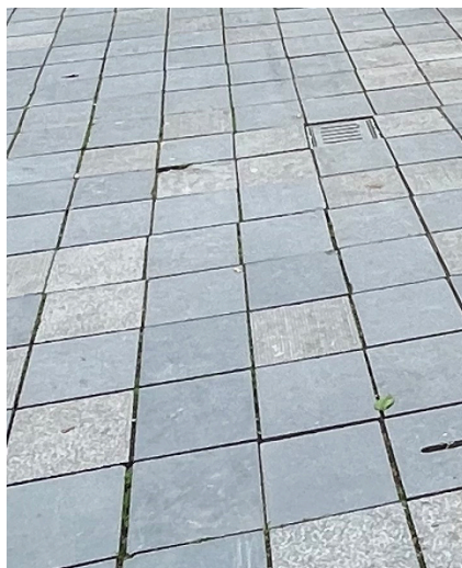
F natuursteen waterelement hergebruik tegels Gemeenteplein opgeruwd met zuurbehandeling
