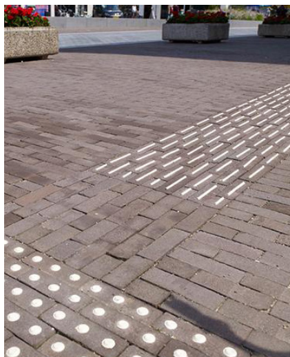
toegankelijkheid geleidelijnen, epoxyhars
