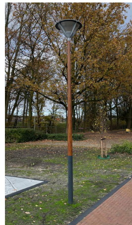
● paaltop op houten mast met stalen voet
