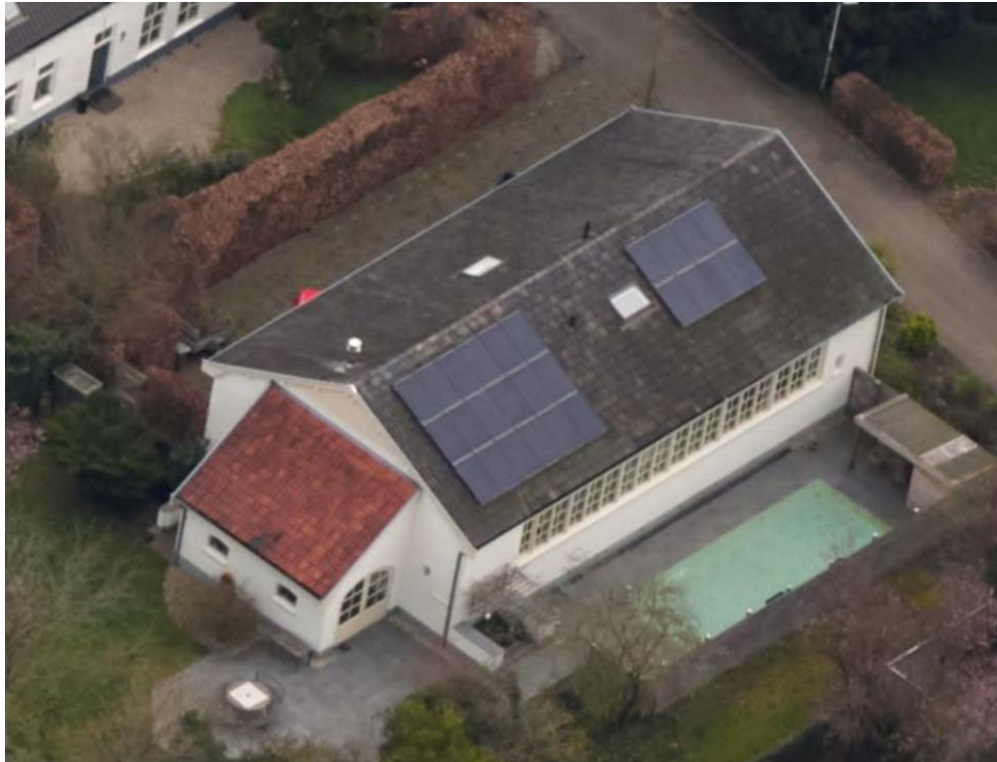
Luchtfoto van het gebouw met zicht op de achterzijde.
