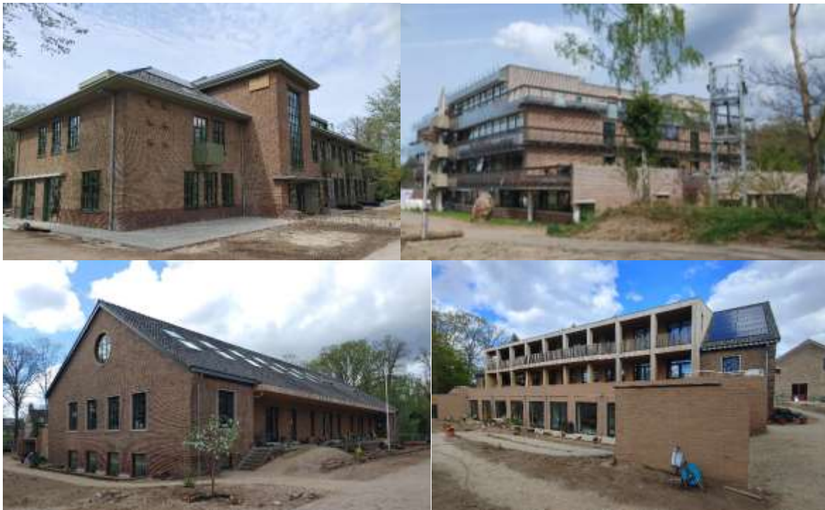
Vanaf linksboven met de klok mee: Woningen in vml. legeringsgebouwen; 'De Groene Afslag', met hotel, restaurant en vergaderfaciliteiten, in hergebruikt voormalig militair opleidingsgebouw; Verbouwing vml. museumgebouw tot appartementen, achterzijde en voorzijde.
