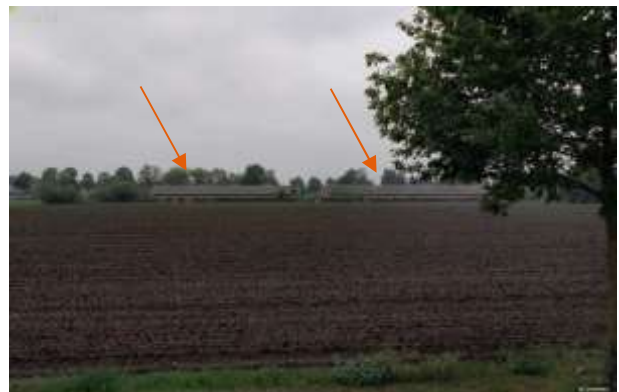
Foto 11: schuren met asbestverdacht dak op achterterrein van Burgt 10a (vanaf de Bovenstehuis)
