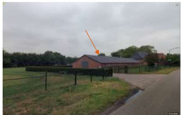
Foto 15: schuren met asbestverdachte daken op perceel van Burgt 8
