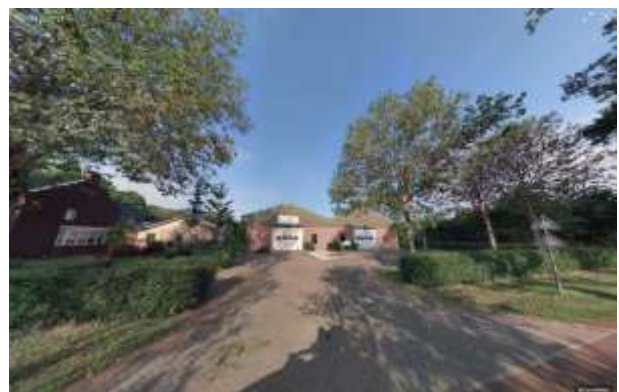
Foto 5: installatiebedrijf aan het adres Bovenstehuis 1
