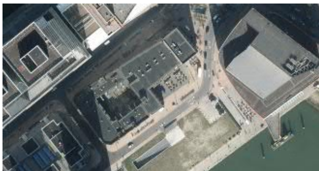
Luchtfoto van het uitgekermde pakhuys Leidsche Veem met aangesloten nieuwbouw (1996-1998)
