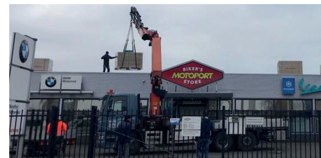
Zonnepanelen worden geplaatst. Foto van SAENZ
