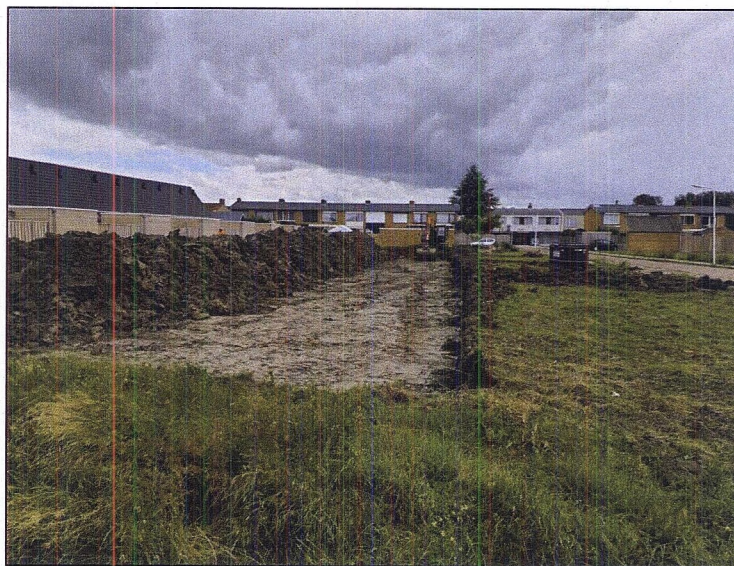
Afb.5 – Verwijderen van de bovenlaag in het opsporingsgebied.
