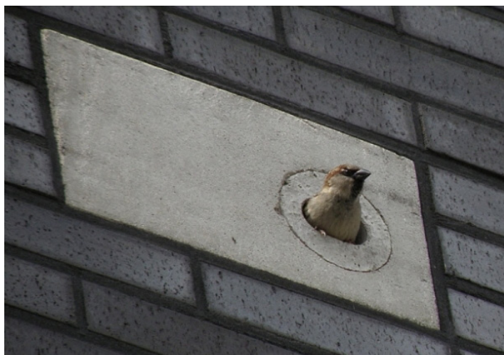
Voorbeeld van een nestkast in de gevel
