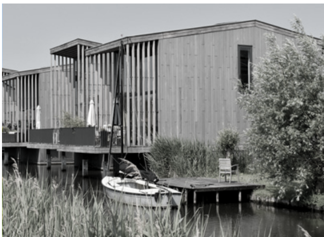
Voorbeeld van een waterwoning
