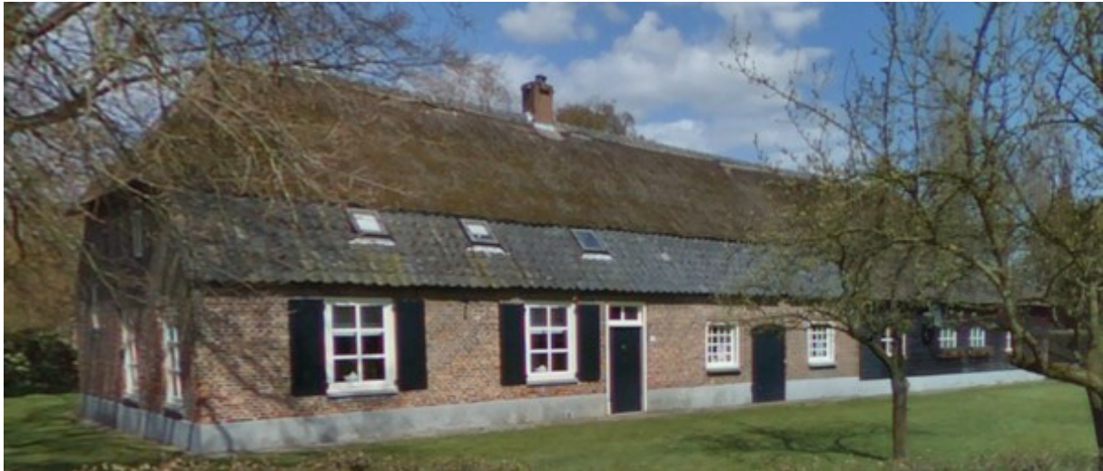
Afbeelding: Achterste Brug 16.
