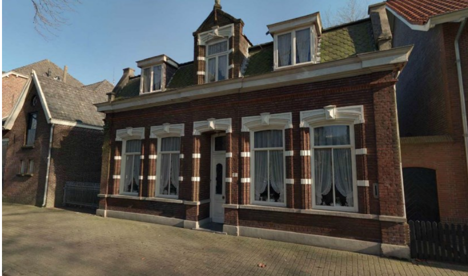
Afbeelding: de woning aan de Maastrichterweg 5 in Valkenswaard.
