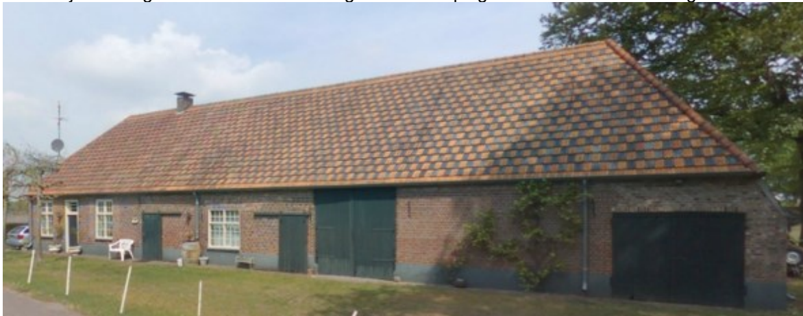
Afbeelding: Boerderij Achterste Brug 20.
