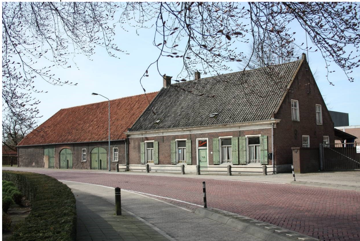
Afbeelding: voormalige markante dorpscafé De Oranjeboom met boerderijgedeelte en fundament van brouwerij uit 1744 (maart 2011)
