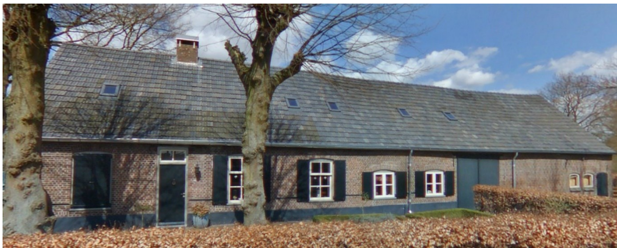
Afbeelding: Achterste Brug 12
