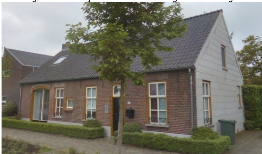
Afbeelding: Woonhuis met bedrijfsgedeelte Reisvennestraat 22.
