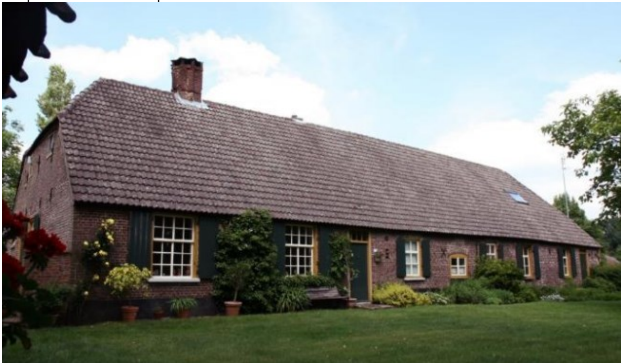
Afbeelding: Boerderij Achterste Brug 14.
