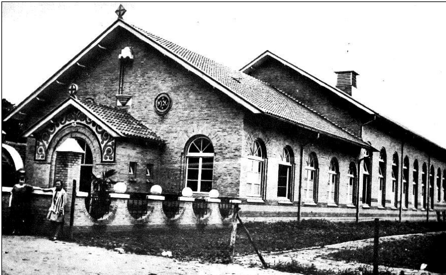
Afbeelding: Het r.k.-verenigingsgebouw, gebouwd in 1926 waar onder meer toneeluitvoeringen werden gegeven. Bij de bouw van de nieuwe Sint-Nicolaaskerk in 1929 diende het als noodkerk. 302
