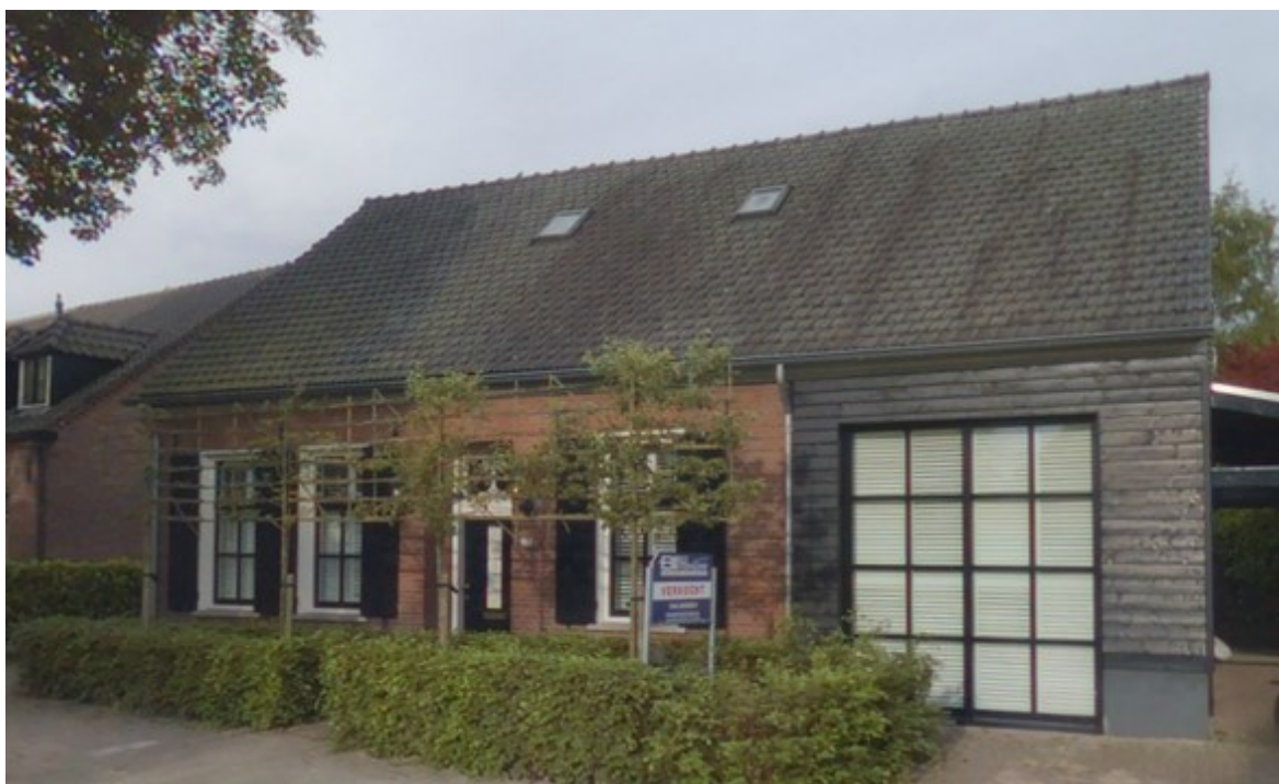
Afbeelding: Woonhuis Dommelstraat 13 in Dommelen.
