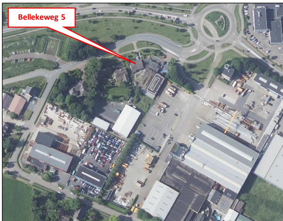
Figuur 1. Luchtfoto met ligging bedrijfslocatie
