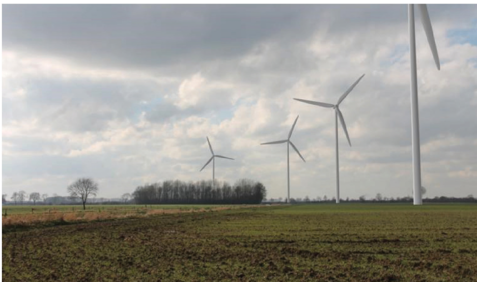
Figuur 26: Windpark op een afstand van 5 keer de tiphoogte; de windturbines zijn beeldbepalend en zeer dominant aanwezig.
