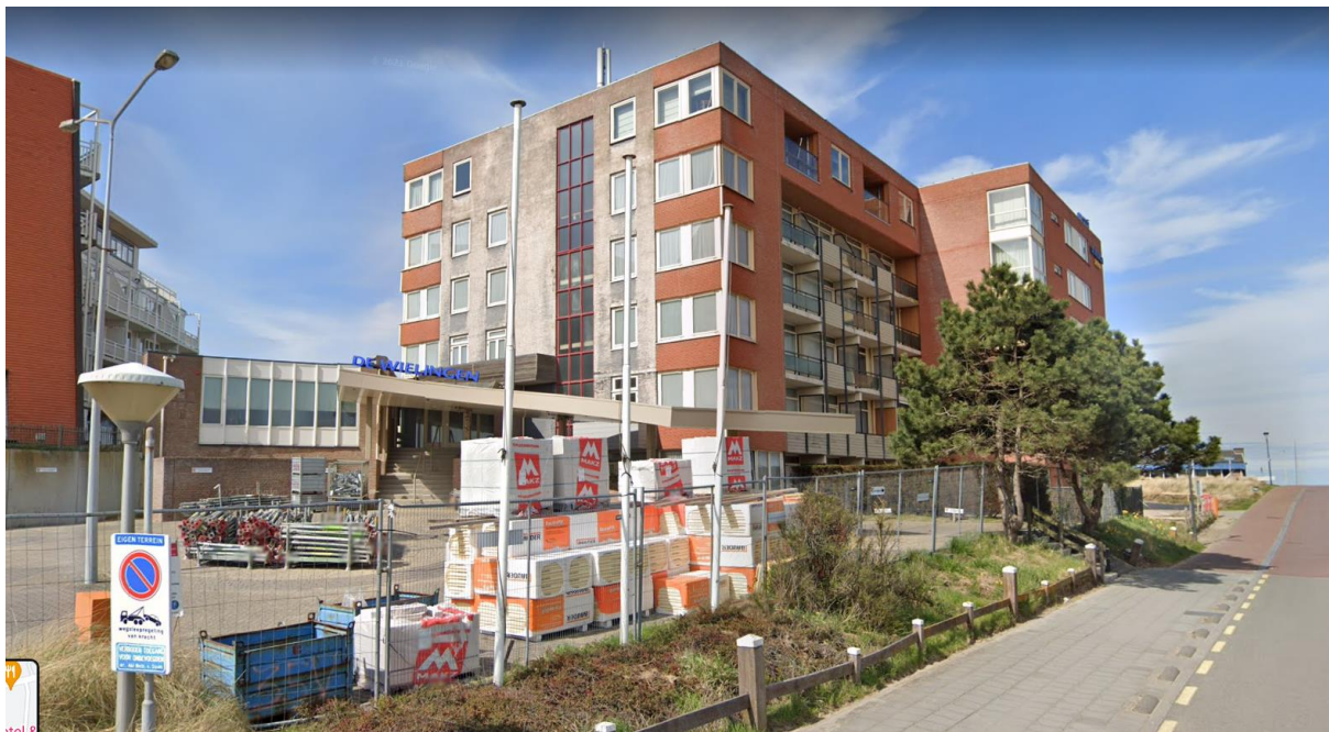
Figuur 10: Huidige situatie hotel De Wieringen, aanzicht vanuit zuidelijke richting
