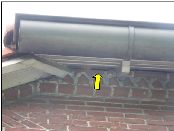
Figuur 15. Geschikte opening voor vleermuizen met toegang tot spouwmuur/ loze ruimtes onder het dak.
