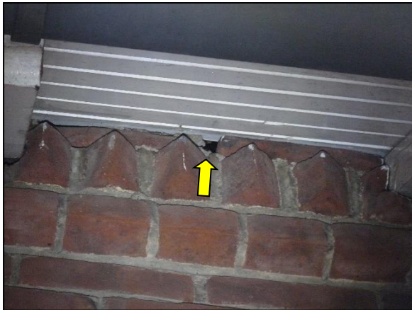
Figuur 13. Geschikte opening voor vleermuizen met toegang tot spouwmuur/ loze ruimtes onder het dak.
