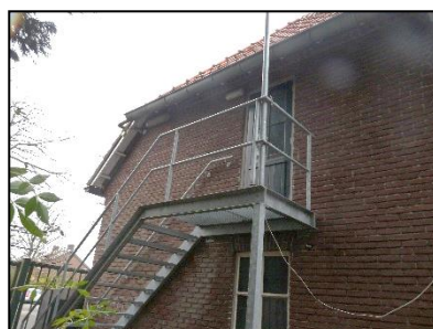
Figuur 7. Westzijde onderzoekslocatie.
