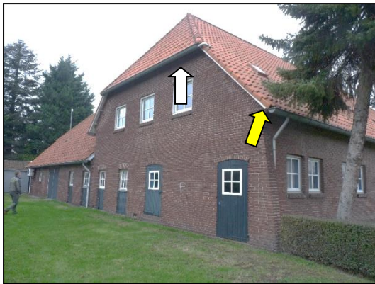
Figuur 9. Geschikte openingen voor huismus en gierzwaluw (witte pijl) en geschikte opening onder dakpannen voor huismus (gele pijl).
