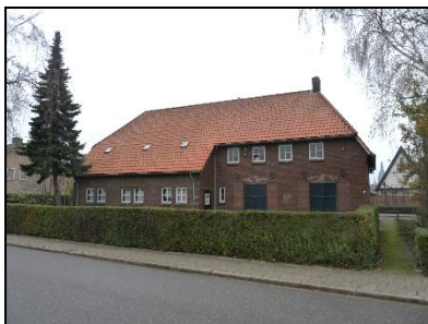
Figuur 3. Oostzijde onderzoekslocatie.
