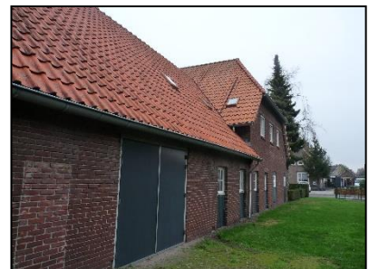
Figuur 5. Zuidzijde onderzoekslocatie.
