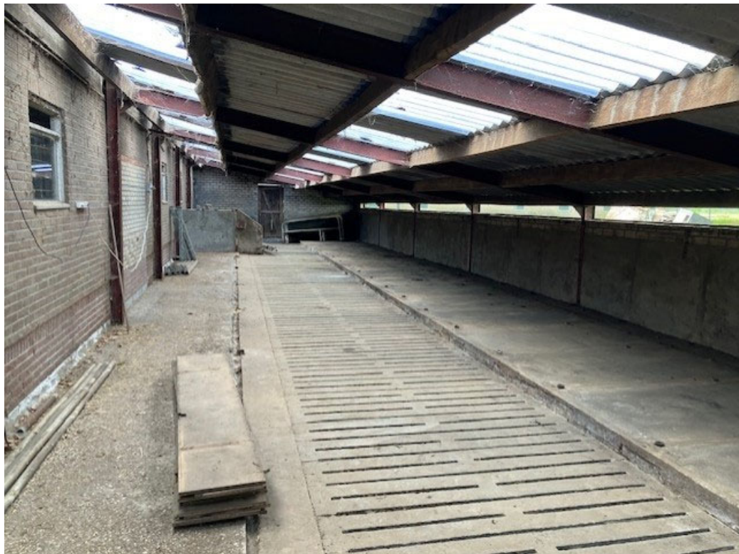
• Afbeelding 13: Binnenzijde te slopen aanbouw melkveestal
