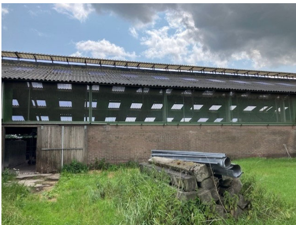
• Afbeelding 11: Buitenzijde te slopen rundveestal
