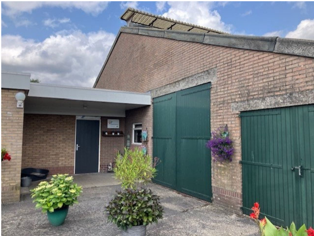
• Afbeelding 21: Platdak blijft behouden, gevel rundveestal wordt gesloopt
