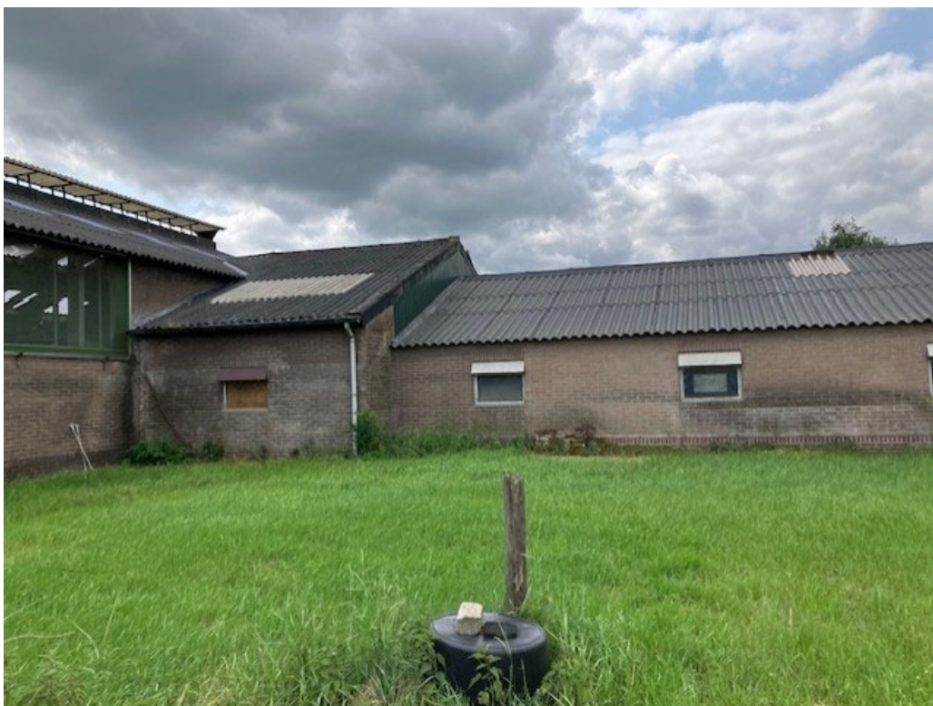
• Afbeelding 10: Links te slopen rundveestal en rechts omgebouwde varkensstal
