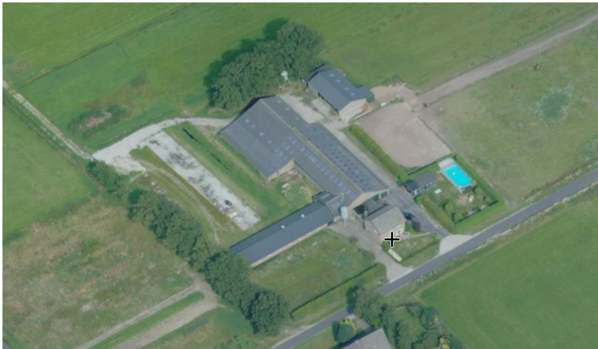
Figuur 2.1.1: Luchtfoto locatie Roerdompweg 11 te Heusden (bron: streetsmart.cyclomedia.com).
