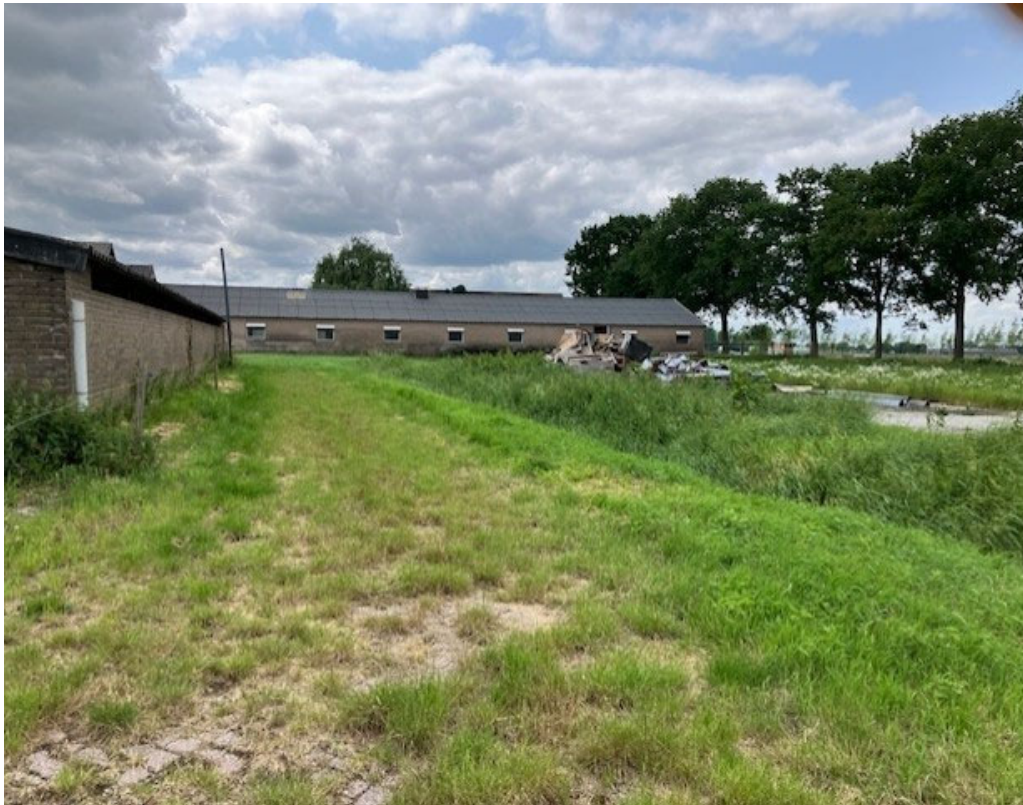
• Afbeelding 12: Linksaanbouw melkveestal en rechts sleufsilo beiden te slopen
