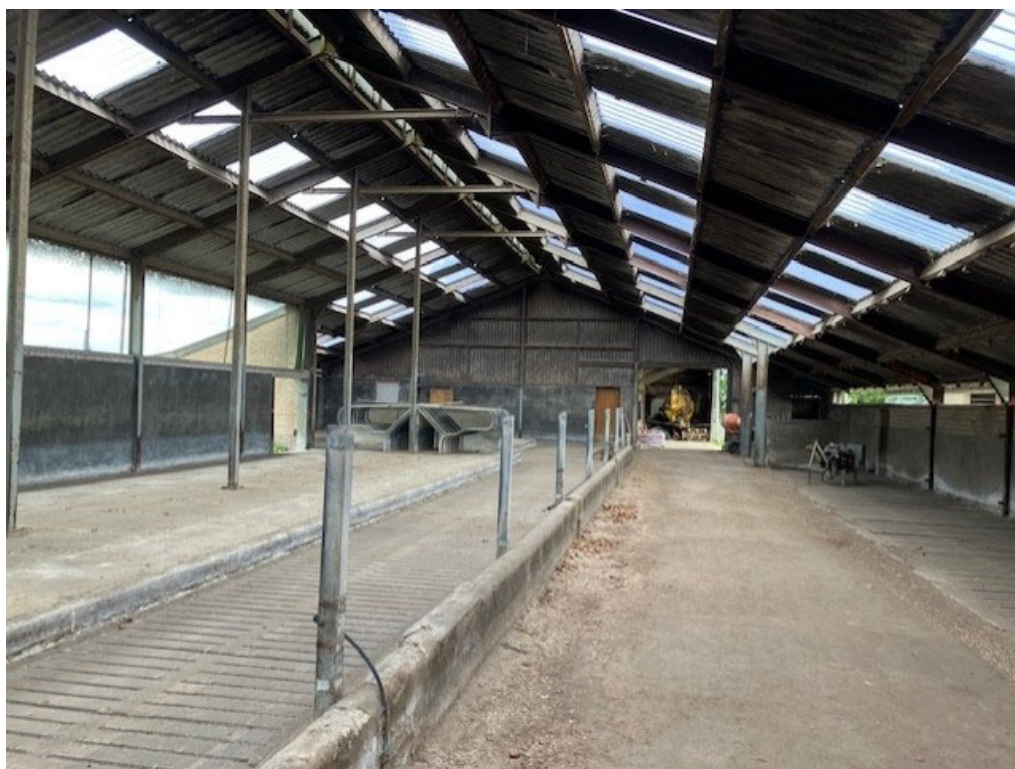
• Afbeelding 19: Te slopen rundveestal, paardenstal blijft behouden aan de achterzijde
