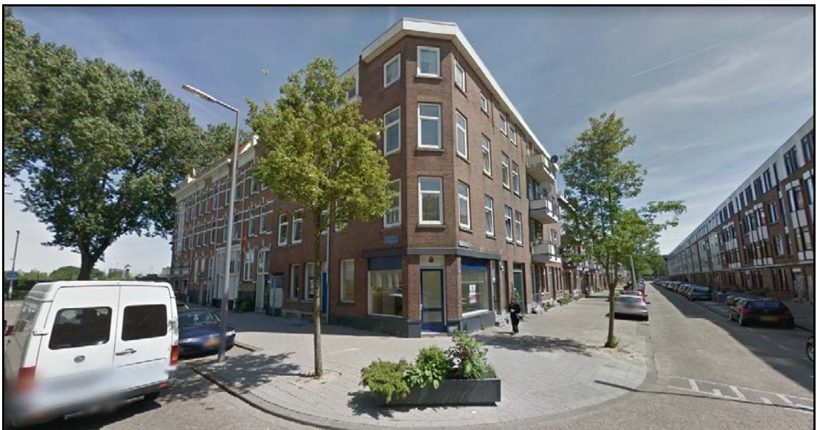
Afbeelding 4: Zicht op huidige bebouwing vanaf hoek Hilledijk/Putselaan (boven) en hoek Tweebosstraat/Martinus Steijnstraat (onder).
