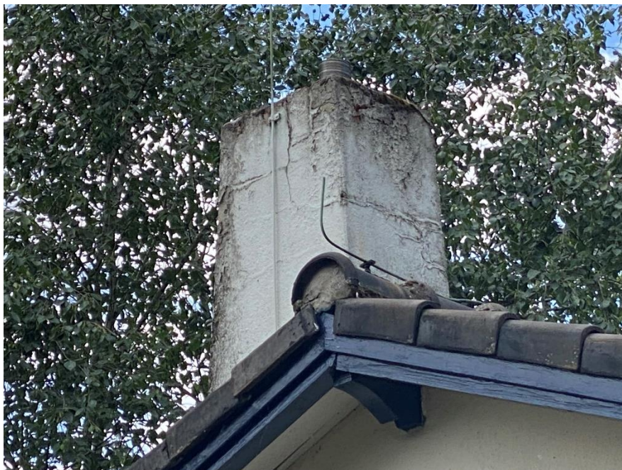
Foto 1: De dakconstructie is ongeschikt voor broedvogels met jaarrond beschermde nesten. Zo is te zien dat de nokpannen met beton zijn afgedicht, waardoor er geen plek is voor gierzwaluwen om deze te gebruiken. Ook de dakconstructie aan de kopse kant is vanwege het gladde houtwerk ongeschikt om als invliegplek te dienen
