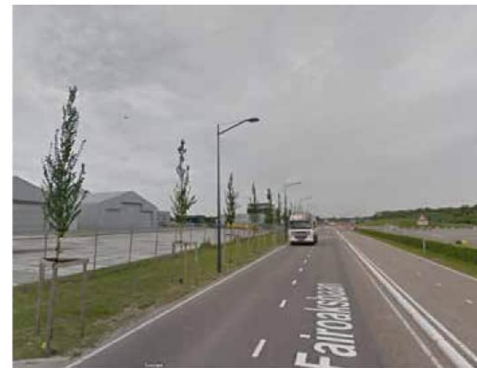
De Fairoaksbaan: gesloten hangars aan de noordzijde
