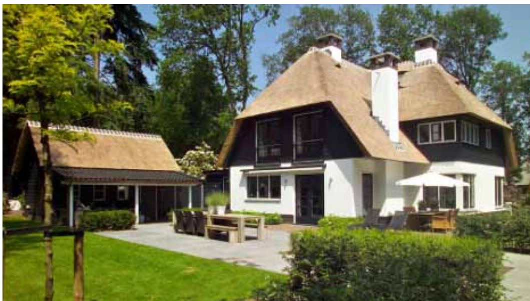
Afbeelding 64. Villa heeft op zichzelf staande tuin met terras en losse bijgebouwen
