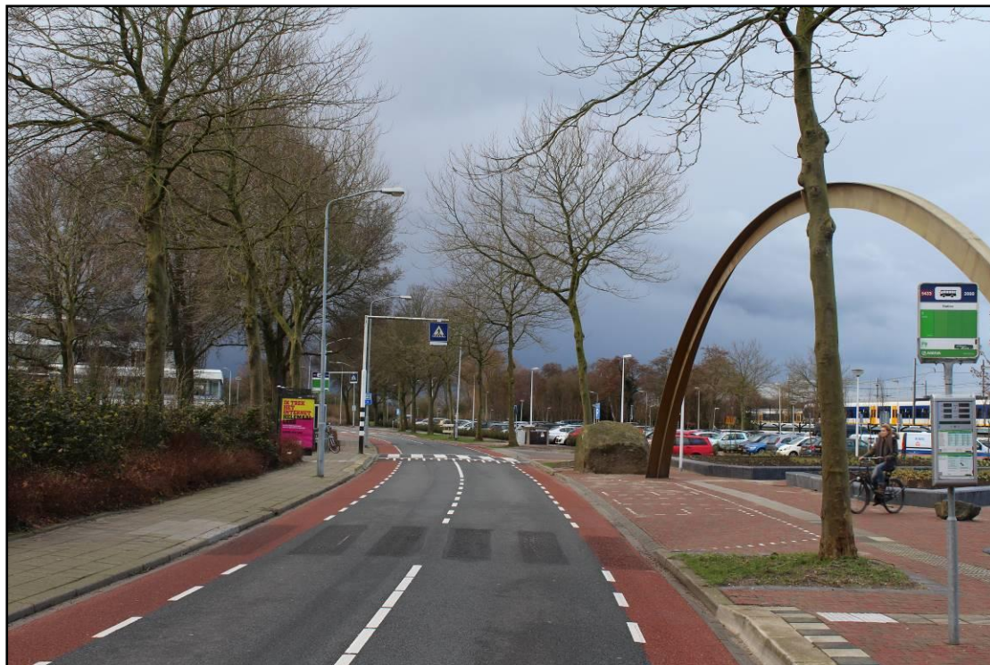
Afbeelding 2: De inrit van het stationsterrein in februari 2016 na uitvoering van de werkzaamheden
