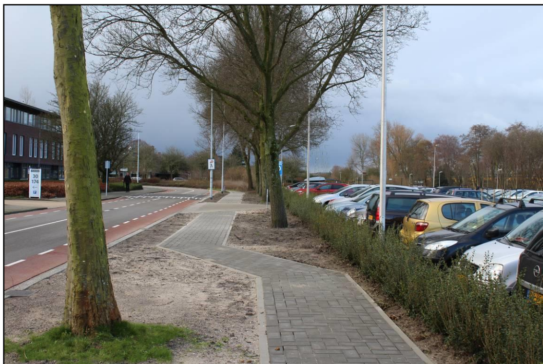
Afbeelding 4: De locatie van de uitbreiding van de parkeerplaats in februari 2016 na uitvoering van de werkzaamheden
