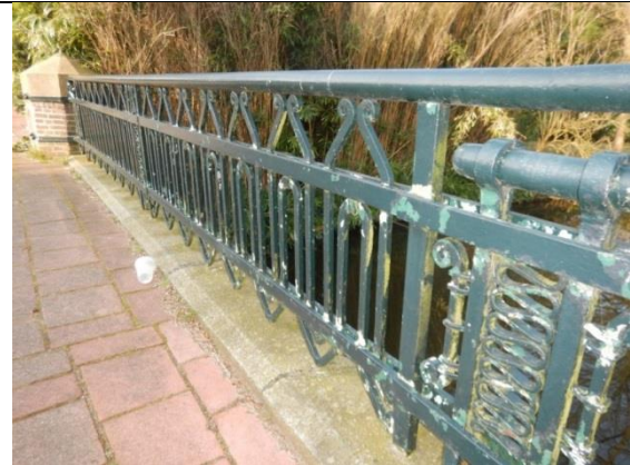
Matige uitstraling ten gevolge van afbladdering schilderwerk op de leuning.
