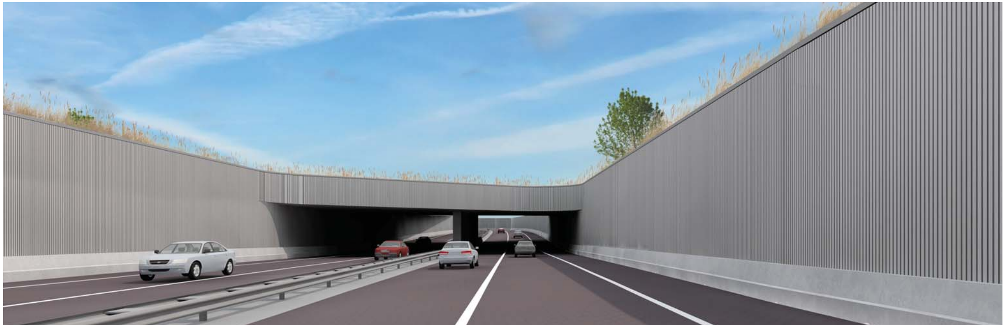
↑ ARTIST IMPRESSION OVERGANG VAN KEERWANDEN EN AQUADUCT MET RIETKAAG EN BOMEN LANGS DE VERDIEPTE LIGGING.
