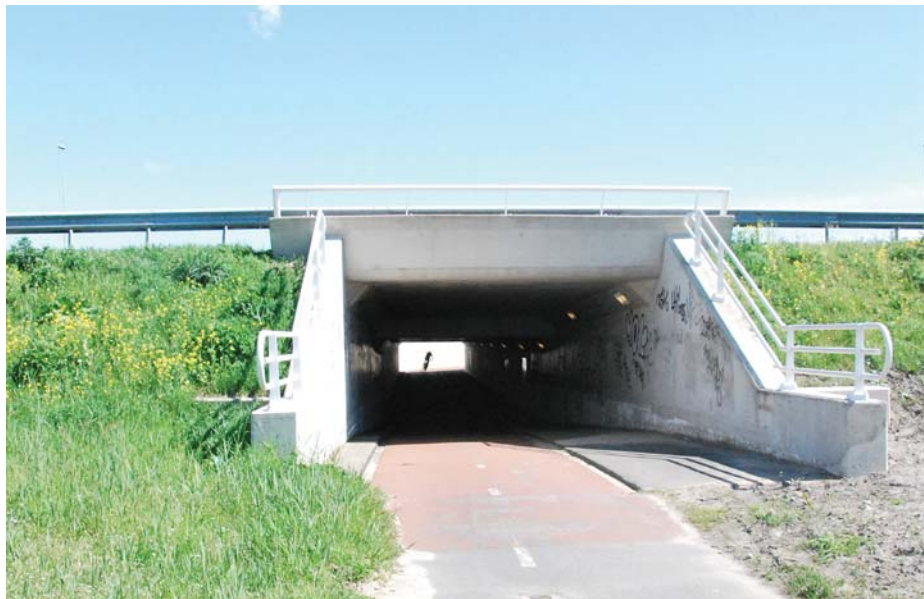
↑ BESTAANDE TE VERWIJDEREN TUNNELDEEL FIETSTUNNEL HOFWEG AAN DE WESTKANT.
