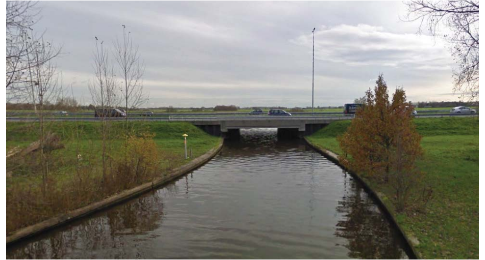
↑ TE VERBREDEN KUNSTWERK (KW34): DUIKERRUG BAKKERSLOOT
