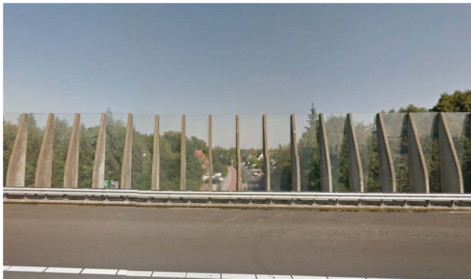
↑ REFERENTIE COULISSEWERKING: STAANDERS MET TRANSPARENT SCHERM (A2 T.H.V. ZALTBOMMEL)
