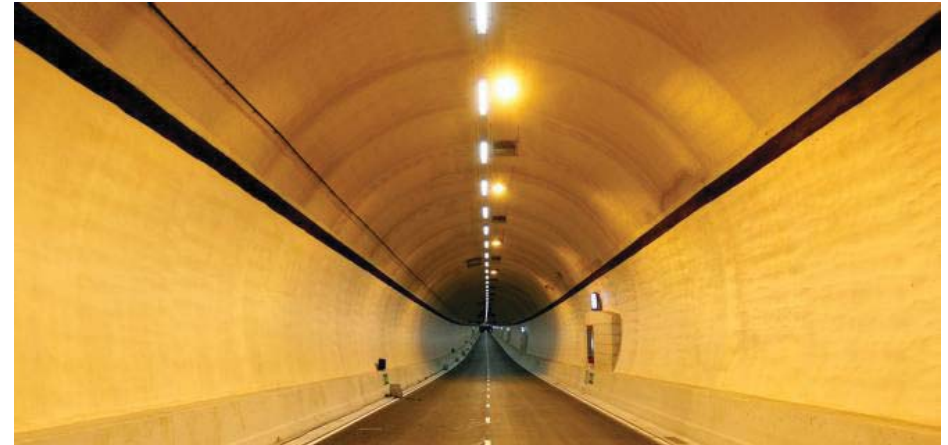
↑ REFERENTIE ONGEWENST BEELD VERLICHTING TUNNEL: HUBERTUSTUNNEL
