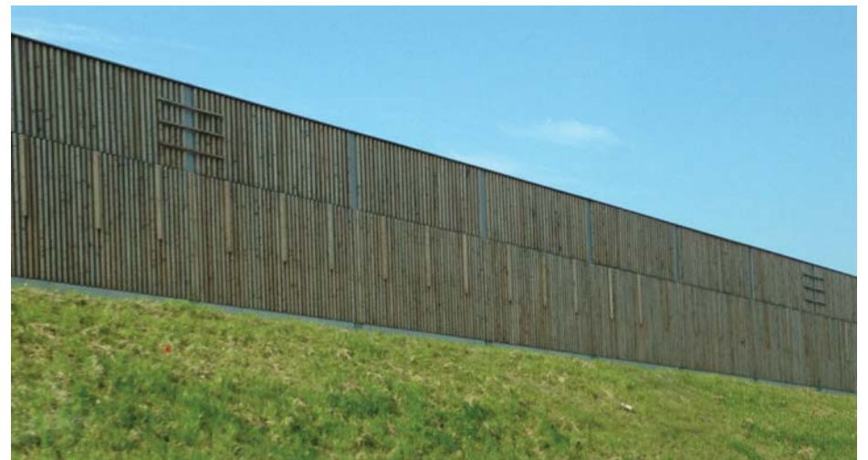
↑ REFERENTIE VAN GELUIDSSCHERMEN VOORZIEN VAN EEN RELIËF ZONDER DE RITMIEK VAN STAANDERS. DIT BEELD VOLDOET ECHTER NIET AAN DE EIS T.A.V. EEN DUURZAAM MATERIAAL.
