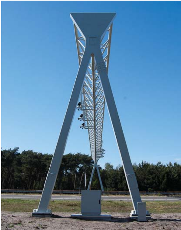
↑ PLAATSING SCHAKELKASTEN TUSSEN PORTAALPOTEN
