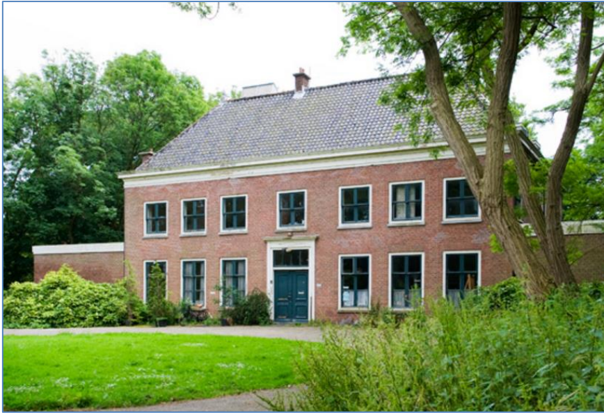
Figuur 3 Bestaande situatie voorzijde
