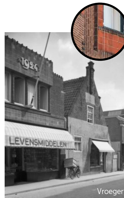
Langstraat 77 rond het jaar 1930. Het pand in Amsterdamse school, rijk uitgevoerd met keramieken tegels en smeedijzeren bouwjaar. De vlaggenmast als as op de gevel rijk trots vooruit.
