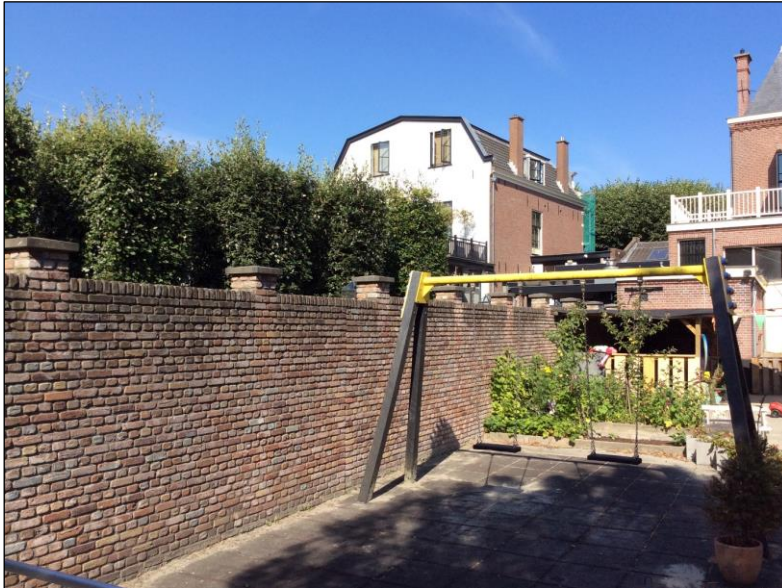
Figuur 14: De tuinmuur op de perceelgrens tussen Voorstraat 21 en 23 dateert uit het recente verleden en werd opgetrokken
