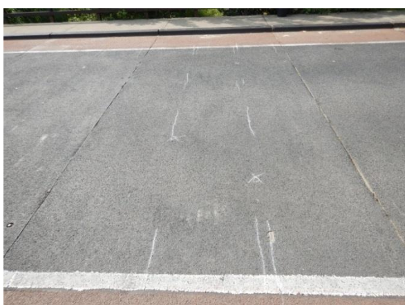
Afbeelding 8: 02BV12 Patroon scheuren
