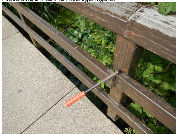
Afbeelding 26: 10V05 Knieregel los
