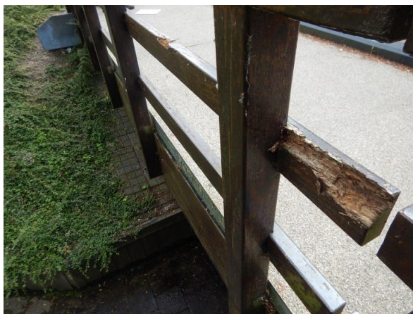
Afbeelding 23: 02V12 Knieregel ingerot
