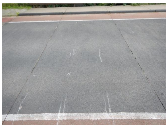
Afbeelding 9: 02BV12 Patroon scheuren
