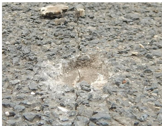
Afbeelding 11: 10BV05 Detail scheur in kunststof dek
