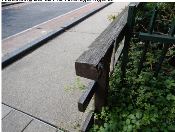
Afbeelding 25: 10BV05 Splinter kop handregel
