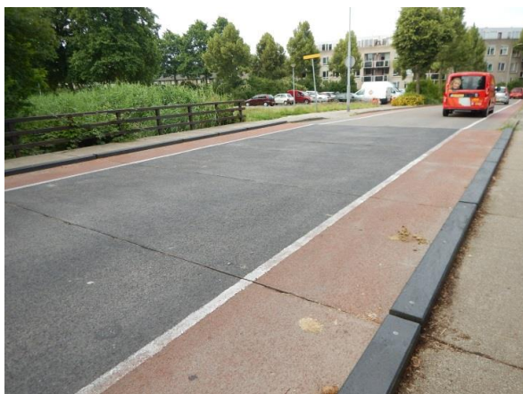
Afbeelding 6: 10BV05 Bovenzijde rijdek. Scheuren tekenen niet af.
