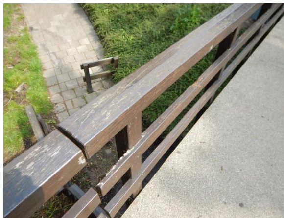
Afbeelding 24: 02V12 Knieregel ingerot
