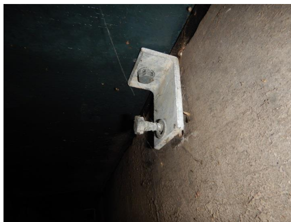
Afbeelding 19: 10BV05 Losse bevestigingsmiddelen onderzijde
