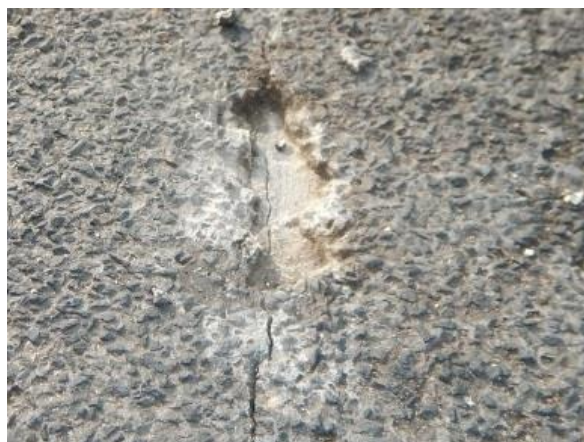
Afbeelding 5: 02BV12 Scheur in rijdek
