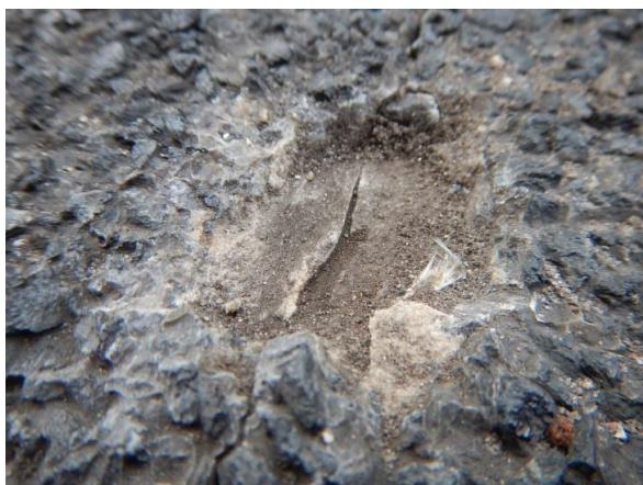
Afbeelding 10: 10BV05 Detail scheur in kunststof dek
