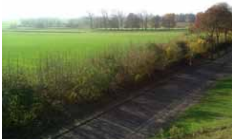
UITKIJKPUNT OP TALUD
