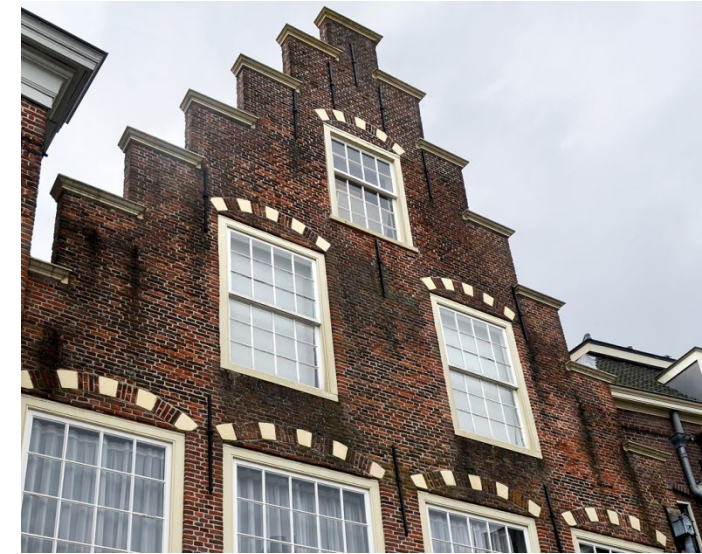
100. Ambachtshuis, achtergevel (noord), geveltop, voorzien van vensters met kozijnen van omstreeks 1740, terwijl de ramen in 1980-1982 zijn gereconstrueerd.
