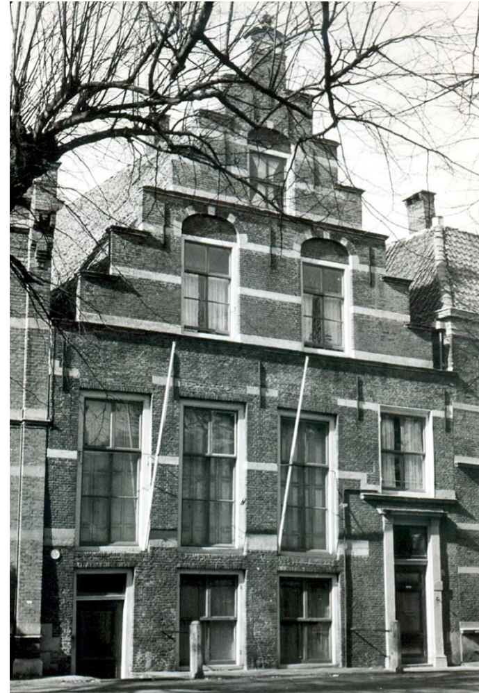
7. Ambachtshuis, voorgevel (zuid) in 1960 (GAV Beeldbank). De traveeën zijn van ongelijke breedte, omdat de gevel in 1635-1637 de breedte had gekregen van de drie linker traveeën, en pas in 1638-1639 in oostelijke richting is uitgebreid toen de steeg (t.p.v. de hoofdingang, rechts) werd overbouwd. Deze overbouwing had ook gevolgen voor de trapgevel, die eveneens verbreed en dus verhoogd moest worden, waardoor de onderste treden van de geveltrap onder de onderste waterlijst kwamen te liggen in plaats van erboven.
