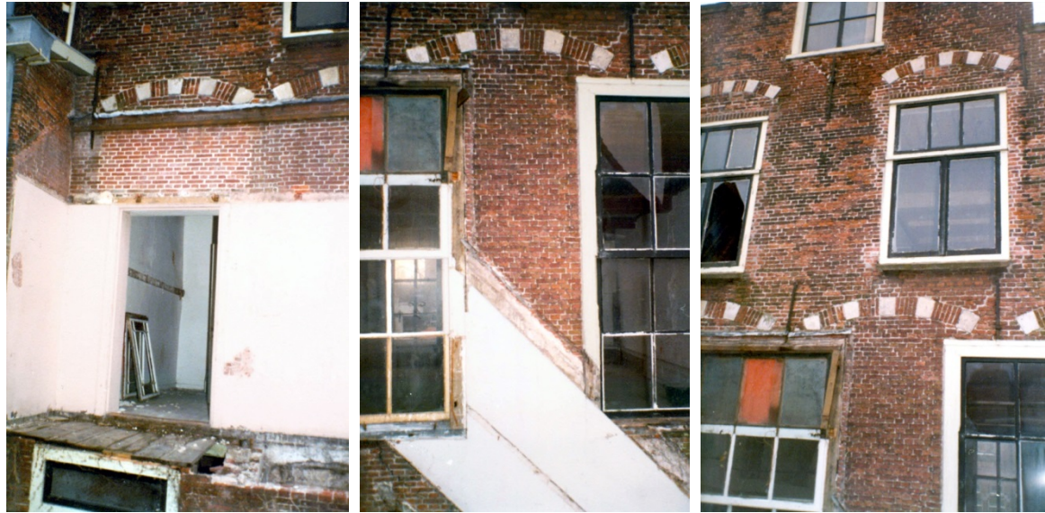
69. Ambachtshuis, achtergevel (noord), met de trapaanbouw van omstreeks 1870 die leidde naar de overloop boven de voormalige steeg, 1953 (GAV Beeldbank). 70. Ambachtshuis, achtergevel (noord), ter plaatse van de verdieping na verwijdering van de trapaanbouw tijdens de restauratie, 1980 (GAV Beeldbank); v.l.n.r.: het oostelijke deel met de doorgang, het centrale deel en het centrale deel met de zolder- en vlieringvensters: in 1810-1830 zijn de vier vensters op de bel-etage vervangen door drie exemplaren, voorzien van empire ramen, waarbij de vier zeventiende-eeuwse vensterbogen met hun blokjes zijn gehandhaafd; omstreeks 1870 heeft het oostelijke (links) venster plaatsgemaakt voor de doorgang van de nieuwe trapaanbouw naar de overloop boven de voormalige steeg.
