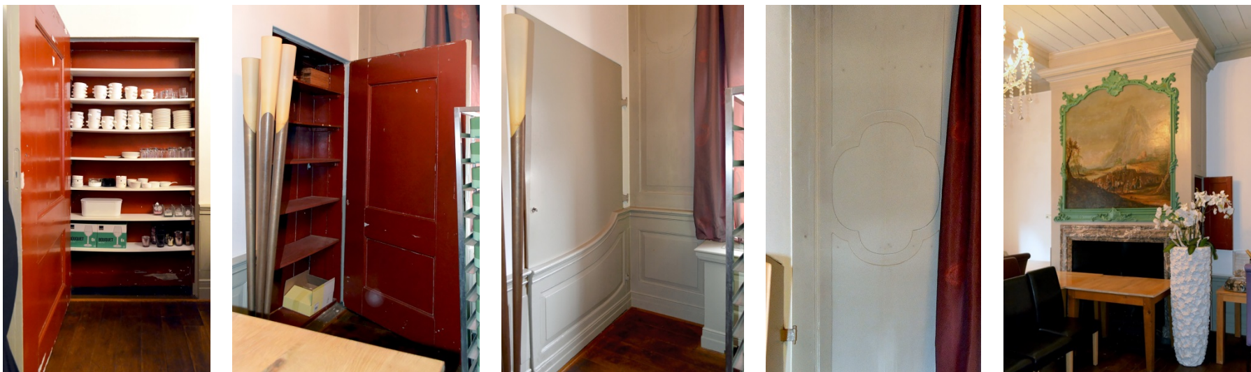
173. Baljuwhuis, begane grond, gang, achter- of schouwkamer, westmuur, zuidelijke wandkast (omstreeks 1740) waar zich tot 1980 een (gedichte) doorgang bevond naar een keuken achterin van de vm. steeg (nu garderobe); het interieur van de kast is een reconstructie uit 1980-1982.
