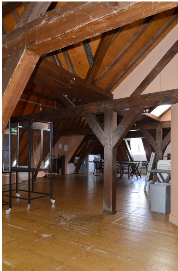
234. Baljuwhuis, zolder vanuit het zuidoosten, met zicht op de bodem van de zakgoot boven de standvinken.
