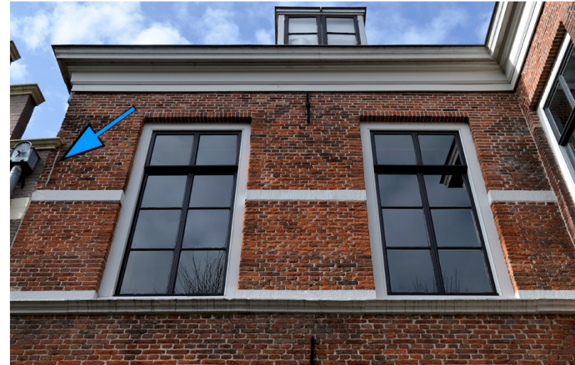
108. Baljuwhuis, voorgevel (zuid), bovenzijde van westbeuk, is omstreeks 1740 voorzien van een rechte lijst; het metselwerk eronder is in 1980-1982 hersteld; pijl wijst naar de schouder van de onderste trede van de geveltrap van het Ambachtshuis, waar de gevel van het Baljuwhuis omheen is gemetseld.
