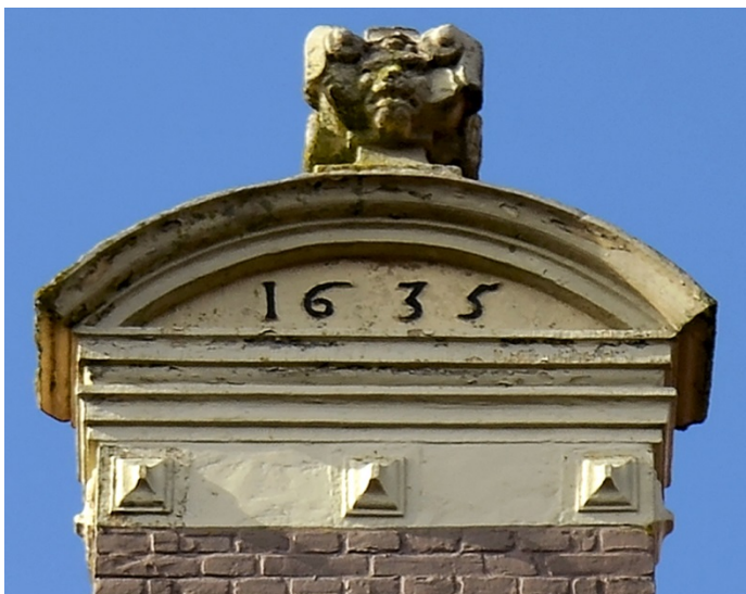
91. Ambachtshuis, voorgevel (zuid), geveltop voorzien van het jaartal '1635' met bovenop het segmentfronton een geblinddoekte kop (waarschijnlijk Vrouwe Justitia). 92. Ambachtshuis, voorgevel (zuid), geveltop, de dekplaten van de geveltrappen zijn vervaardigd van Franse kalksteen (Vaurion) en dateren van 1980-1982.
