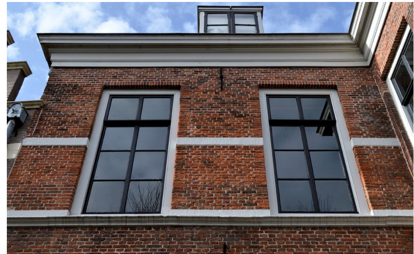
19. Baljuwhuis, bovenzijde van het westelijke deel van de voorgevel, die in 1640-1641 ook een trapegevel zal hebben gekregen, maar omstreeks 1740 een lijstgevel is geworden, aansluitend bij het toen herbouwde oostelijke deel van het huis, 2021.
