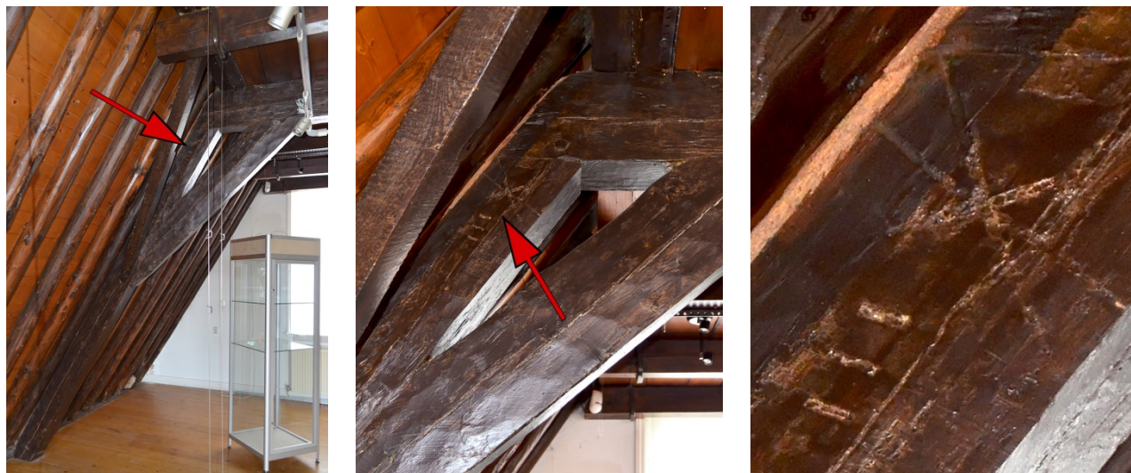
26. Ambachtszolder, zuidzijde van het westelijke been van het noordelijke jukspant; pijl wijst naar een tel- en een vlotmerk, 2021.
