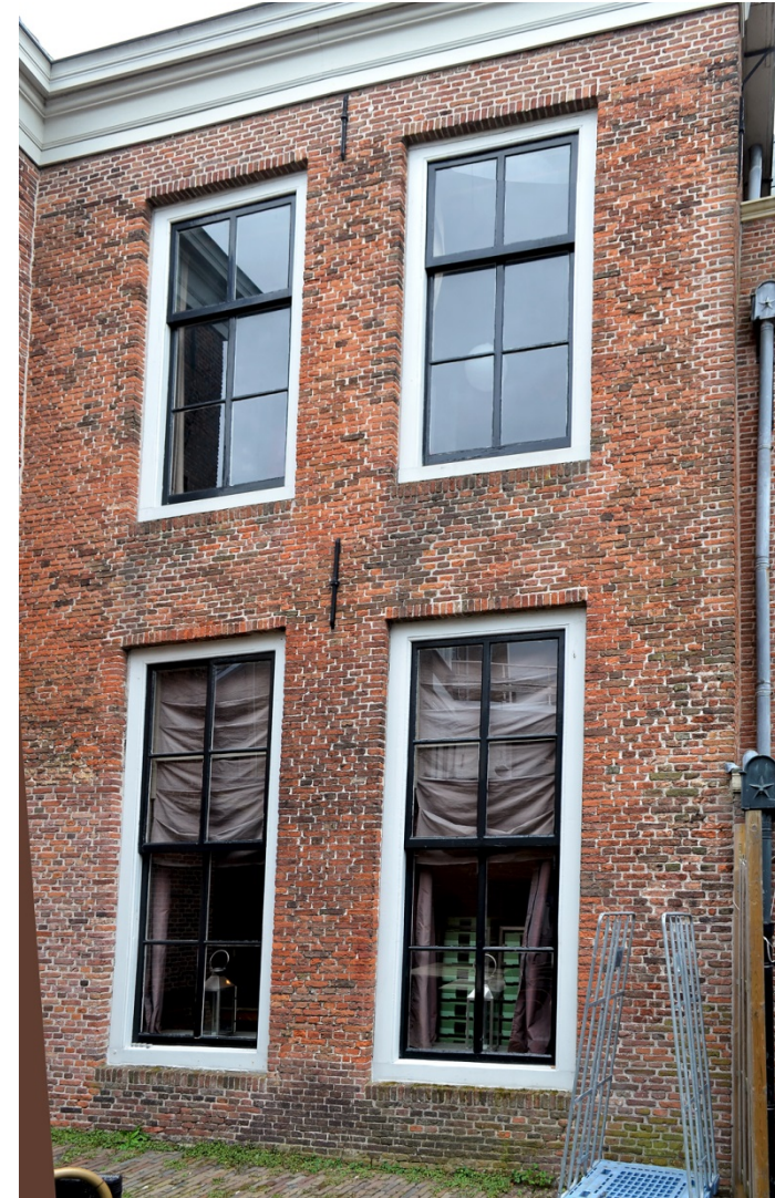
118. Baljuwhuis, achtergevel (noord) en westelijke zijgevel van de oostbeuk, met rechts nog net de westbeuk; de pijlen wijzen naar de overgang in het metselwerk, ontstaan in 1980-1982 door inboetwerk na de sloop van een privaataanbouw. Rechts nog net de berging uit 1982 en de overkapping van vóór 2012.
