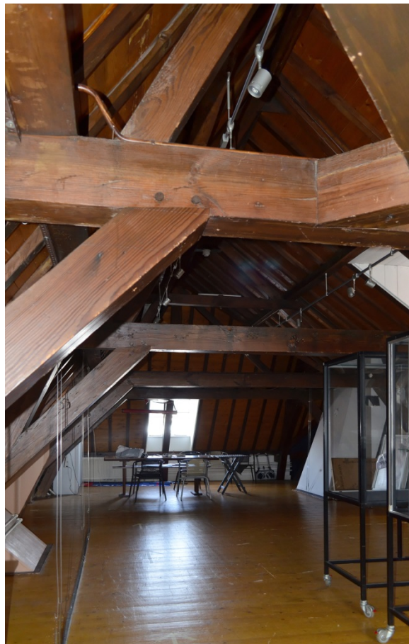
234. Baljuwhuis, zolder vanuit het zuidoosten, met zicht op de bodem van de zakgoot boven de standvinken.
