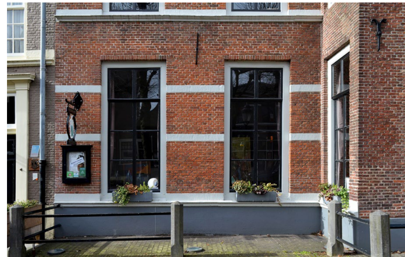
109. Baljuwhuis, voorgevel (zuid), onderzijde van westbeuk, de vensters bezitten kozijnen van omstreeks 1740 en empireramen van 1810-1830.
