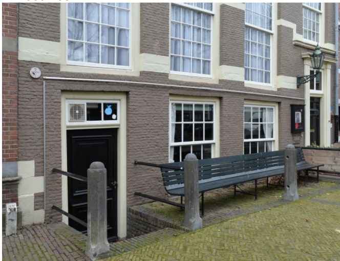
97. Ambachtshuis, voorgevel (zuid), de vensters ter plaatse van het souterrain zijn omstreeks 1870 ingebracht, maar vervangen in 1980-1982, waarbij de ramen zijn gereconstrueerd.
