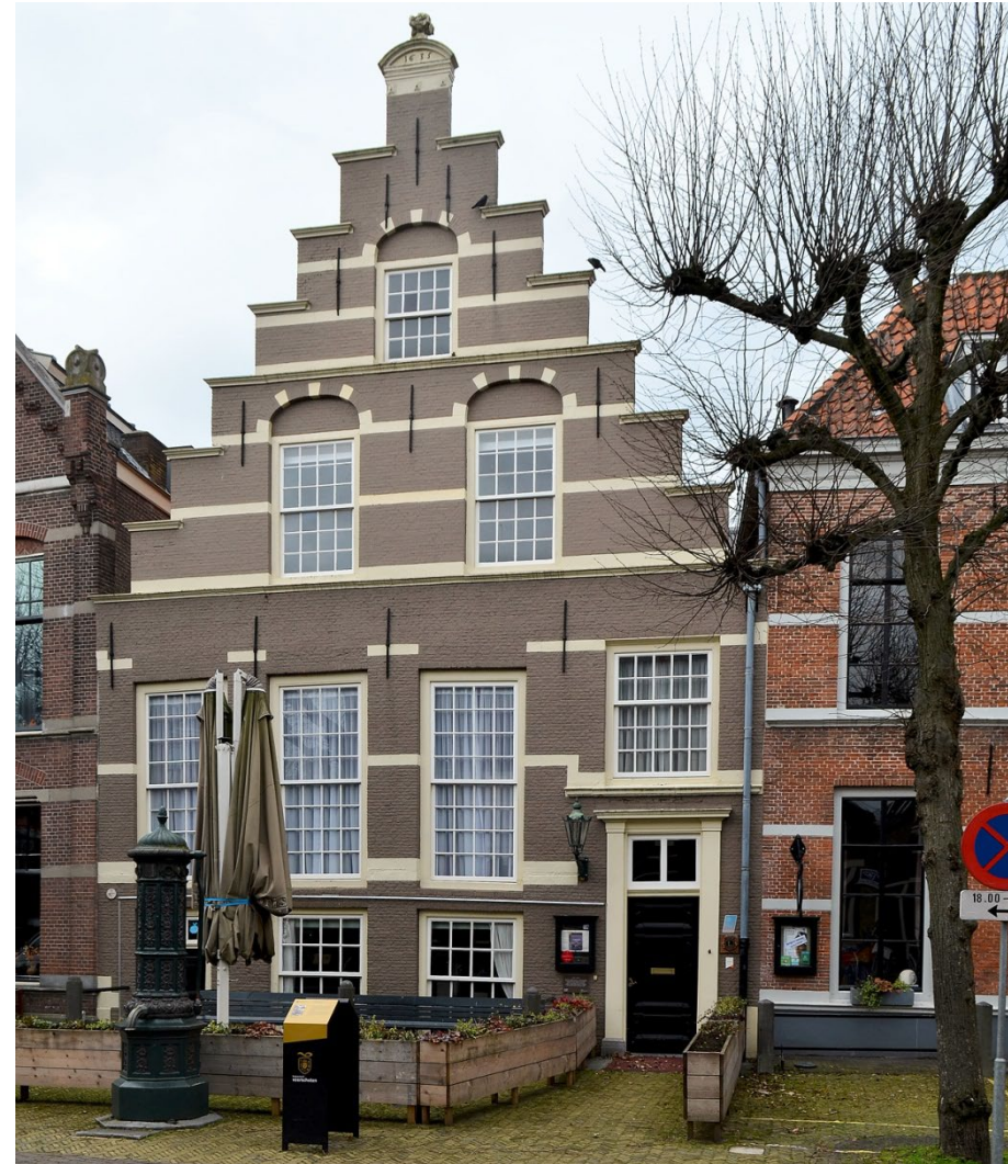
90. Ambachtshuis, voorgevel (zuid), het metselwerk is verrijkt met banden, lijsten en hoek- en boogstenen van (geschilderde) Bentheimersteen; de gevel is in 1980-1982 geschilderd op grond van kleursporen en is na 2000 opnieuw geschilderd in de huidige kleurstelling.
