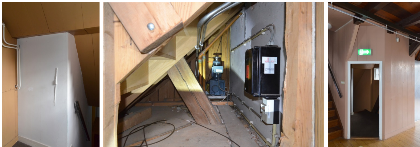
153. Ambachtshuis, zolder, trapportaal (1980-1982) vanuit het zuidwesten, met rechts de trap naar de gang op de verdieping van het baljuwhuis, en links de westelijke zijgevel van het Baljuwhuis met zicht op een anker met schieter, waarschijnlijk van 1640-1641.
