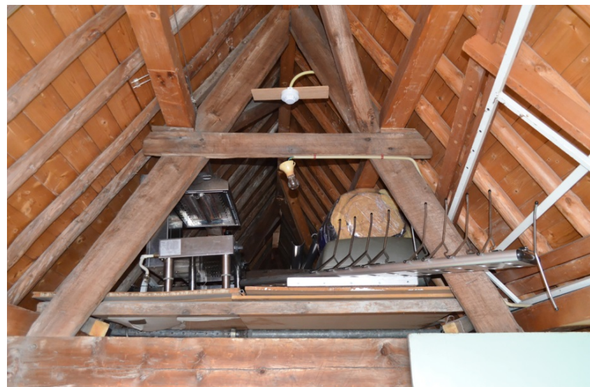
164. Ambachtshuis, vliering, het A-spant bovenop het bovenscheerjuk van het zuidelijke jukspant (met telmerk '1'); de flieringen zijn secundair.
