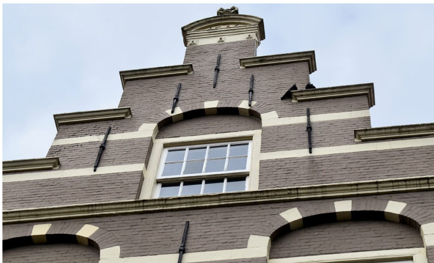
93. Ambachtshuis, voorgevel (zuid), de kozijnen van de vensters dateren van omstreeks 1740, terwijl de ramen in 1980-1982 zijn gereconstrueerd. 94. Ambachtshuis, voorgevel (zuid), de geveltop is vanaf de onderste waterlijst opnieuw opgemetseld, waarschijnlijk eind negentiende eeuw met gebruik van vormbaksteen.
