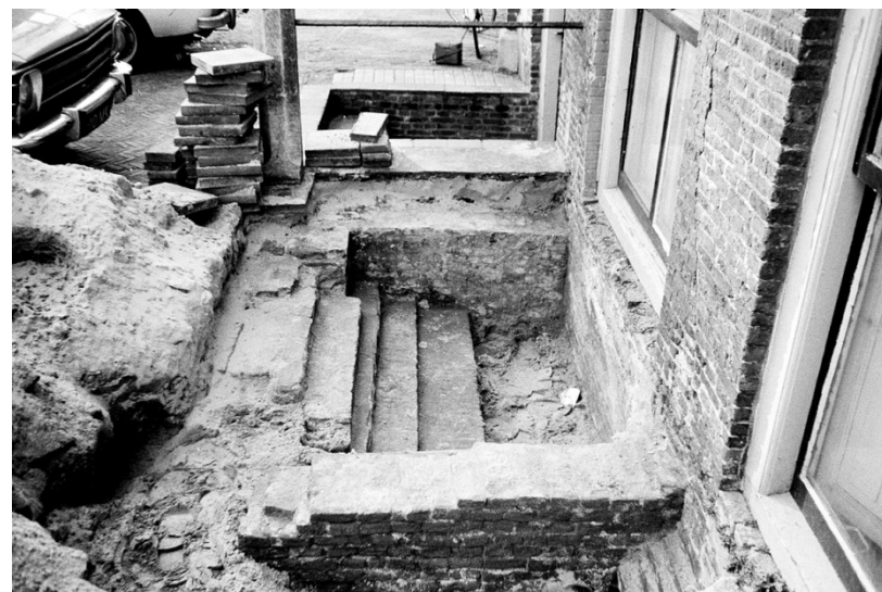
11. Ambachtshuis, voorgevel, opgravingen ter plaatse van de tweede travee vanuit het westen, vanuit het zuidoosten (boven) en oosten, met zicht op de aangetroffen trap naar het souterrain, 1975-1976 (RCE Beeldbank).
