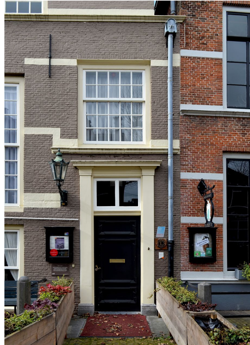
98. Ambachtshuis, voorgevel (zuid), de toegang tot de voormalige steeg, voorzien van een ingangspartij van omstreeks 1740, behalve de deur en het bovenraam (uit 1810-1830) en de in 1980-1982 gereconstrueerde tussenstijl van dit raam.
