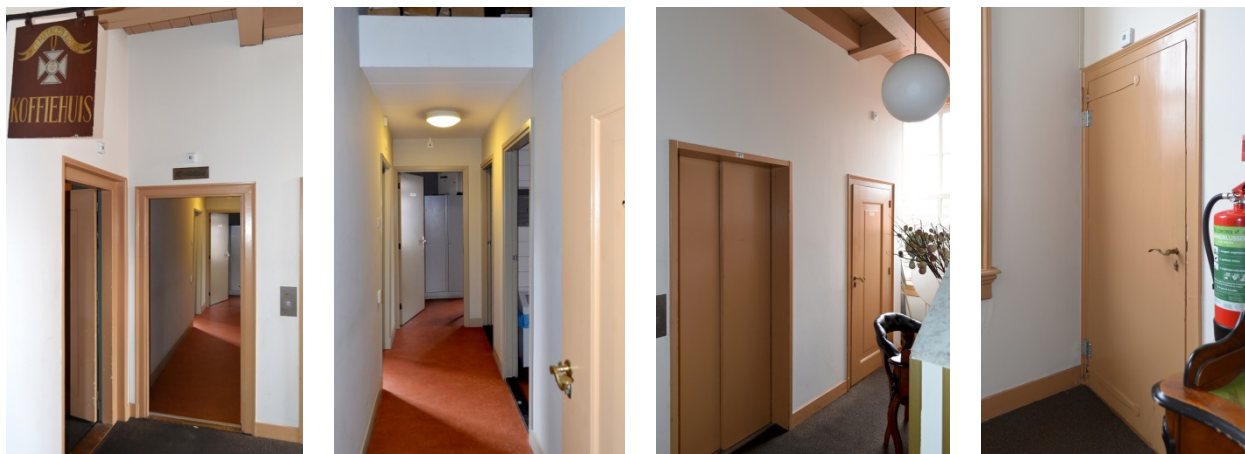
213. Baljuwhuis, verdieping, overloop, noordwesthoek, met links de doorgang (omstreeks 1740) naar kamer 4, en in de noordmuur (1980-1982) de doorgang naar de voormalige kamer 3 (1980-1982), die in 2003 is heringericht.
