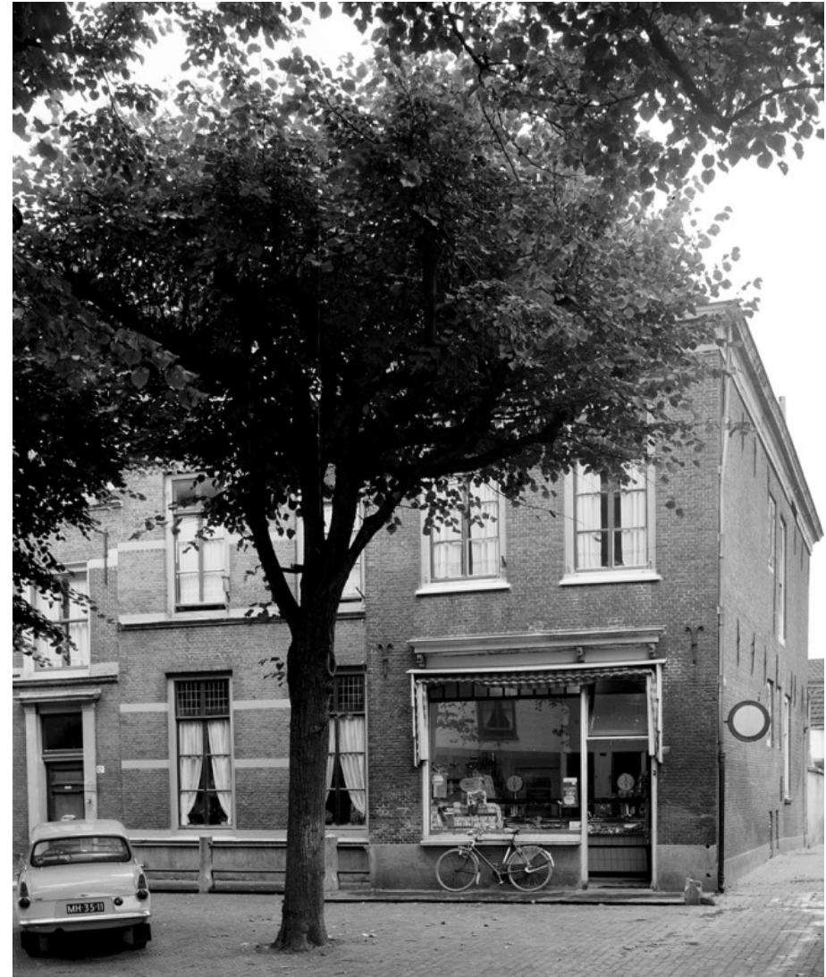
48. Baljuwhuis, voorgevel (zuid), met oostelijk slagerij Van Grundeken, voorzien van een etalagepui van omstreeks 1916, 1963 (RCE Beeldbank).
