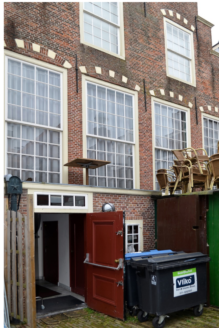
106. Ambachtshuis, achtergevel (noord), de vensters op de bel-etage inclusief de penanten ertussen zijn in 1980-1982 volledig gereconstrueerd, net als de ankerschietter tussen het eerste en tweede venster vanuit het oosten (links).
