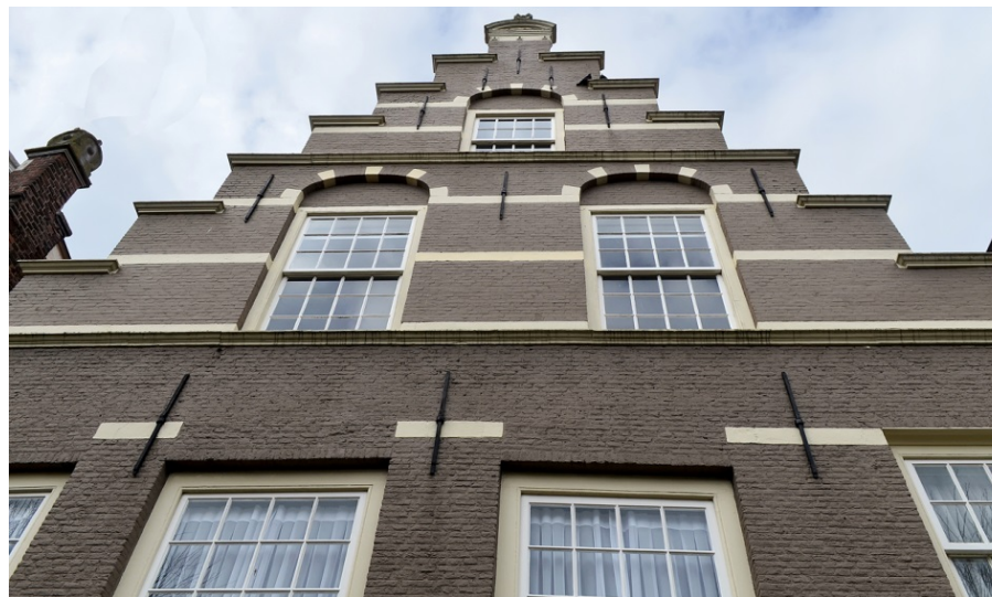
93. Ambachtshuis, voorgevel (zuid), de kozijnen van de vensters dateren van omstreeks 1740, terwijl de ramen in 1980-1982 zijn gereconstrueerd. 94. Ambachtshuis, voorgevel (zuid), de geveltop is vanaf de onderste waterlijst opnieuw opgemetseld, waarschijnlijk eind negentiende eeuw met gebruik van vormbaksteen.
