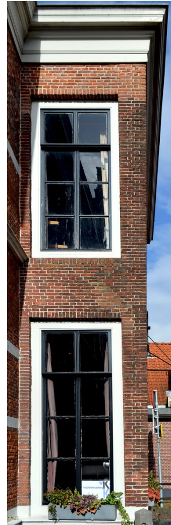
110. Baljuwhuis, westelijke zijgevel van de oostbeuk, de kozijnen dateren van omstreeks 1740, terwijl de ramen in 1980-1982 zijn vernieuwd.
