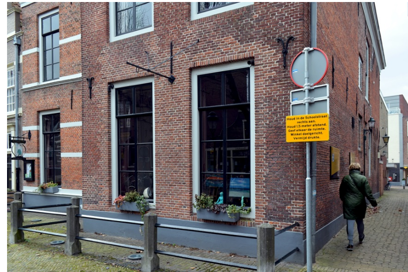
113. Baljuwhuis, voorgevel (zuid), onderzijde van oostbeuk; in 1980-1982 is de etalage van de voormalige slagerij (omstreeks 1916) verwijderd en de pui gereconstrueerd, inclusief de plint en de twee vensters.
