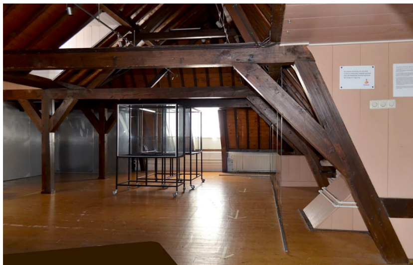
226. Baljuwhuis, zolder vanuit het noorden, met rechts de doorgang (1980-1982) naar de Ambachtszolder.
