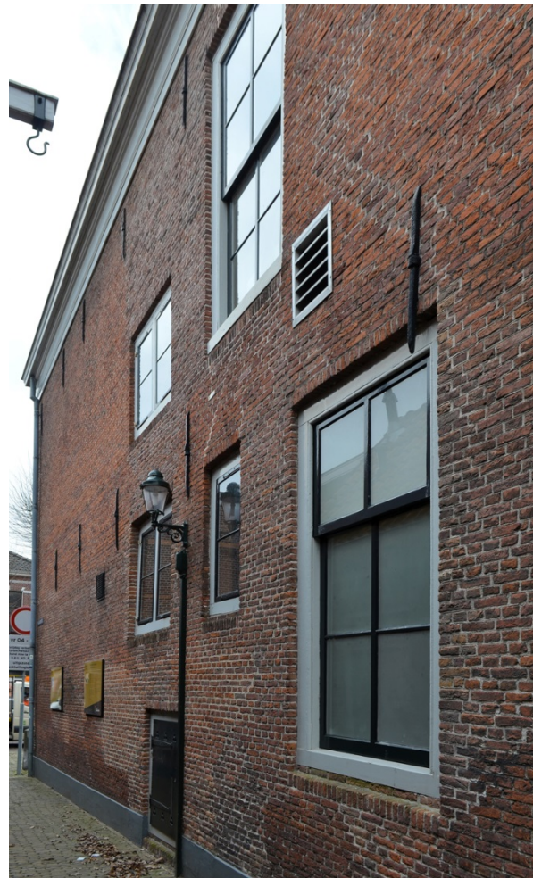
115. Baljuwhuis, zijgevel (oost), alleen centraal bevinden zich vensters; enkele kozijnen dateren nog van omstreeks 1740 of 1810-1830 (noordelijke vensters), maar alle ramen zijn in 1980-1982 gekopieerd, terwijl het kozijn met kelderluik in zijn geheel stamt uit 1980-1982.
