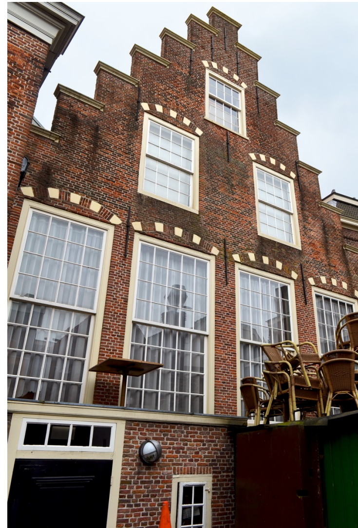
99. Ambachtshuis, achtergevel (noord), het metselwerk is hetzelfde metselwerk als dat van de voorgevel, zij het dat de top hier (eind negentiende eeuw) opnieuw is opgemetseld vanaf de traptreden halverwege het topvenster, en er geen verlaag is aangebracht.
