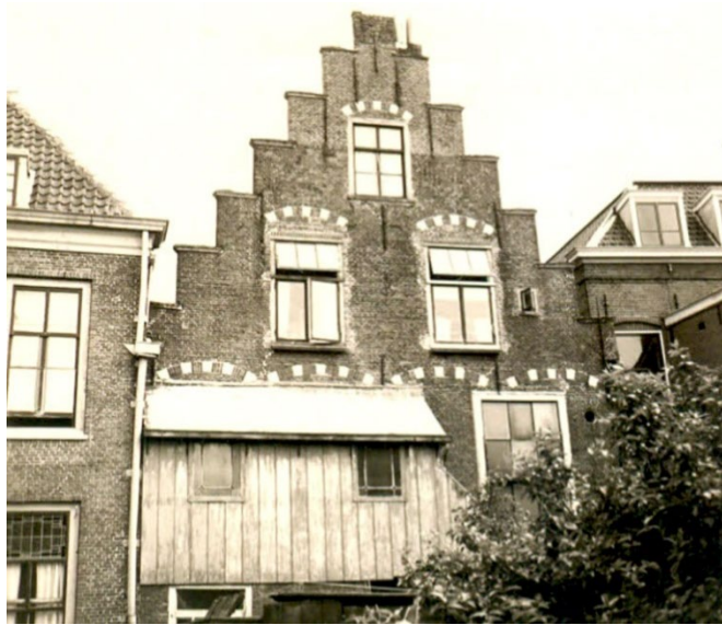
69. Ambachtshuis, achtergevel (noord), met de trapaanbouw van omstreeks 1870 die leidde naar de overloop boven de voormalige steeg, 1953 (GAV Beeldbank). 70. Ambachtshuis, achtergevel (noord), ter plaatse van de verdieping na verwijdering van de trapaanbouw tijdens de restauratie, 1980 (GAV Beeldbank); v.l.n.r.: het oostelijke deel met de doorgang, het centrale deel en het centrale deel met de zolder- en vlieringvensters: in 1810-1830 zijn de vier vensters op de bel-etage vervangen door drie exemplaren, voorzien van empire ramen, waarbij de vier zeventiende-eeuwse vensterbogen met hun blokjes zijn gehandhaafd; omstreeks 1870 heeft het oostelijke (links) venster plaatsgemaakt voor de doorgang van de nieuwe trapaanbouw naar de overloop boven de voormalige steeg.
