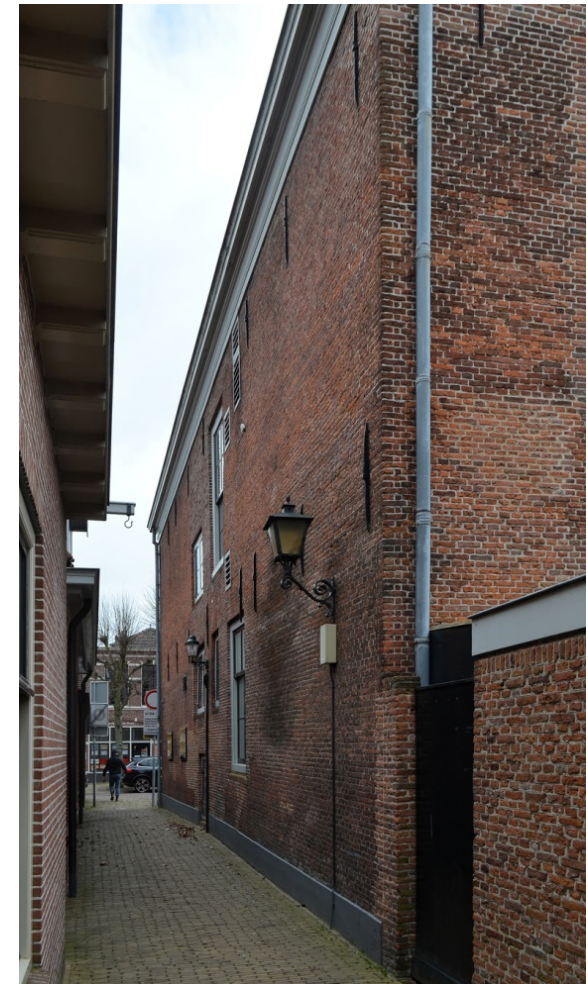
115. Baljuwhuis, zijgevel (oost), alleen centraal bevinden zich vensters; enkele kozijnen dateren nog van omstreeks 1740 of 1810-1830 (noordelijke vensters), maar alle ramen zijn in 1980-1982 gekopieerd, terwijl het kozijn met kelderluik in zijn geheel stamt uit 1980-1982.
