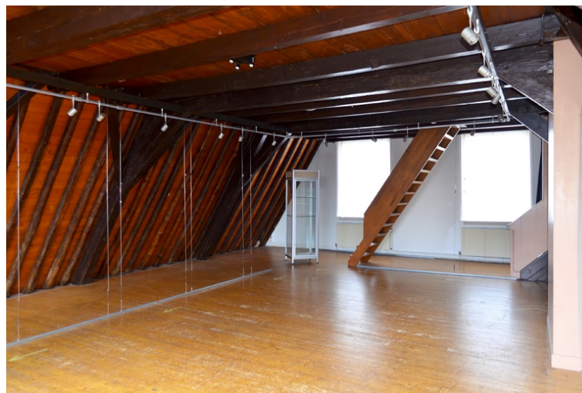
161. Ambachtshuis, zolder, het westelijke spantbeen van het zuidelijke jukspant (met telmerk '1') en zijn genagelde winschoren; geheel boven de strop van een hangbalk. 162. Ambachtshuis, zolder vanuit het zuidoosten, met zicht op de trap (1980-1982) aan de noordzijde naar de vliering en de hangbalken.
