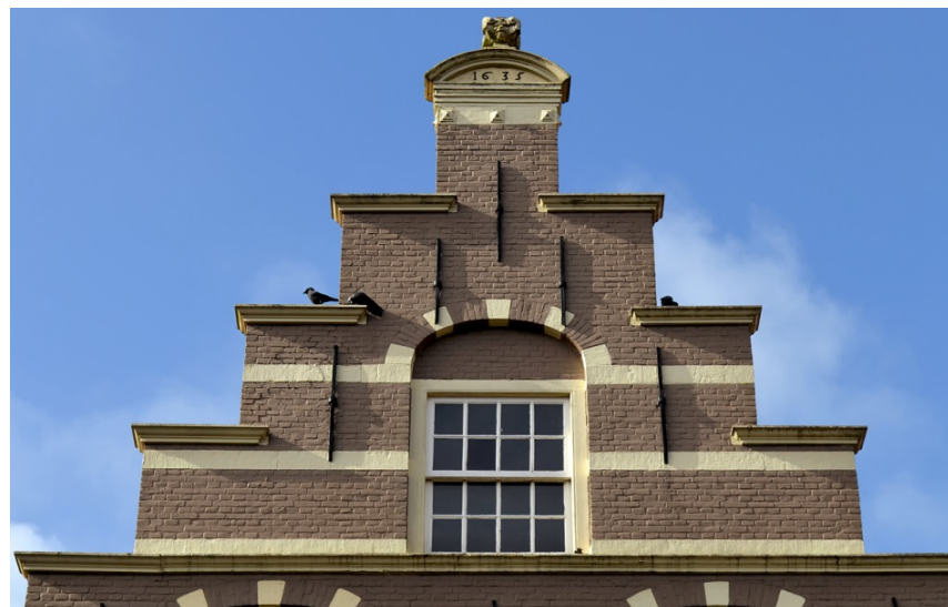
91. Ambachtshuis, voorgevel (zuid), geveltop voorzien van het jaartal '1635' met bovenop het segmentfronton een geblinddoekte kop (waarschijnlijk Vrouwe Justitia). 92. Ambachtshuis, voorgevel (zuid), geveltop, de dekplaten van de geveltrappen zijn vervaardigd van Franse kalksteen (Vaurion) en dateren van 1980-1982.
