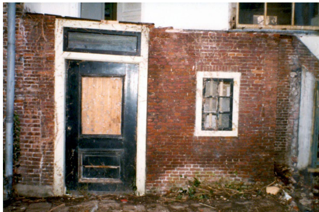
71. Ambachtshuis, achtergevel (noord), de aanbouw met privaat van omstreeks 1740, waarboven zojuist de trapaanbouw uit 1870 is verwijderd, 1980 (GAV Beeldbank).
