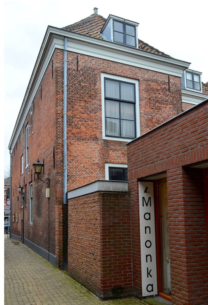
117. Baljuwhuis vanuit het noordoosten met links de Bakkersteeg met de oostgevel en rechts de achtergevel van de oostbeuk; het metselwerk onder de gevelijst (omstreeks 1740) is in 1980-1982 hersteld, terwijl er ook sporen te zien zijn van herstelling in het metselwerk eronder, waar zich in de achttiende en negentiende eeuw aanbouwen bevonden.
