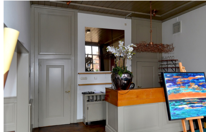
187. Baljuwhuis, begane grond, restaurant-oost, het plafond is in 1980-1982 voorzien van delen met een sierperk tegen een balkenplafond van omstreeks 1740.
