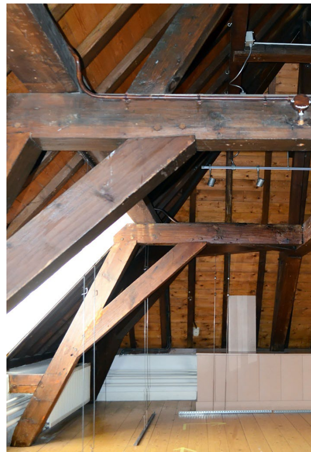
236. Baljuwhuis, zolder, zuidwestzijde vanuit het oosten, met tegen de westelijke borstwering de bovenzijde van de in 1980-1982 gereconstrueerde schoorsteen.
