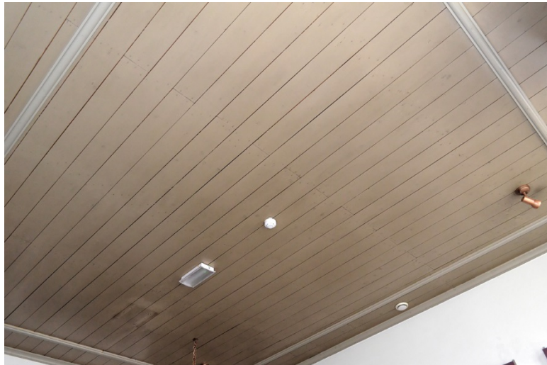
187. Baljuwhuis, begane grond, restaurant-oost, het plafond is in 1980-1982 voorzien van delen met een sierperk tegen een balkenplafond van omstreeks 1740.
