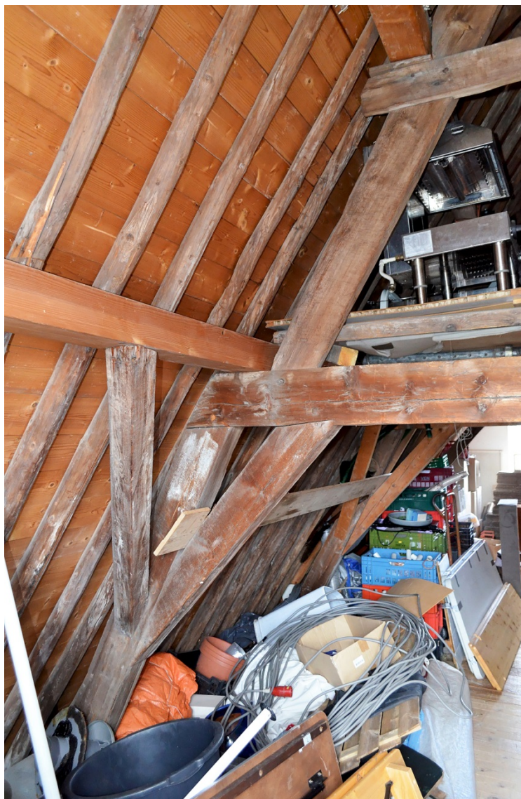
163. Ambachtshuis, vliering, het westelijke been van het zuidelijke bovenscheerjuk (met telmerk '1') met een aan de vernieuwde fliering genagelde windschoor.
