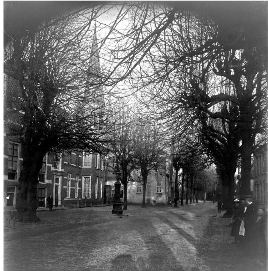
31. Voorstraat vanuit het westen, met links (aan de noordzijde) het Ambachts- en Baljuwhuis, en centraal de dorpspomp, omstreeks 1890 (ELO Beeldbank).
