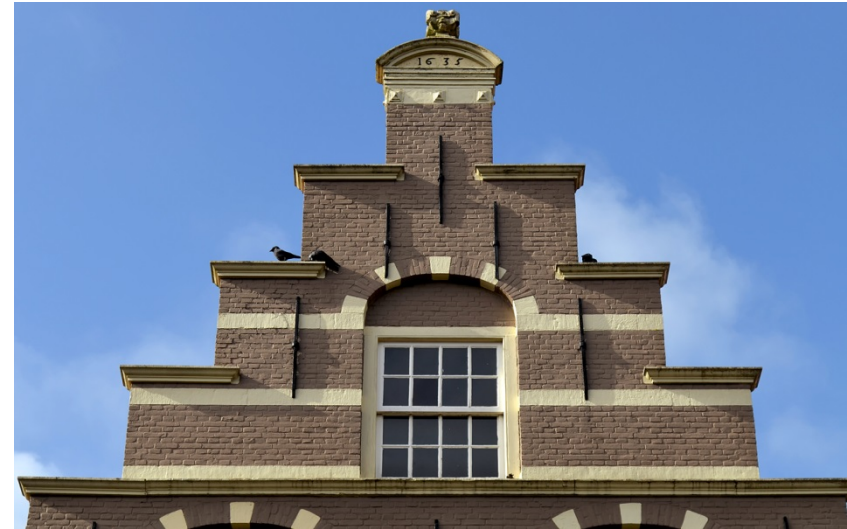
18. Ambachtshuis, voorgevel, top met bovenin het jaartal '1635'; de geveltop is omstreeks 1870 of niet veel later opnieuw opgemetseld, 2021.
