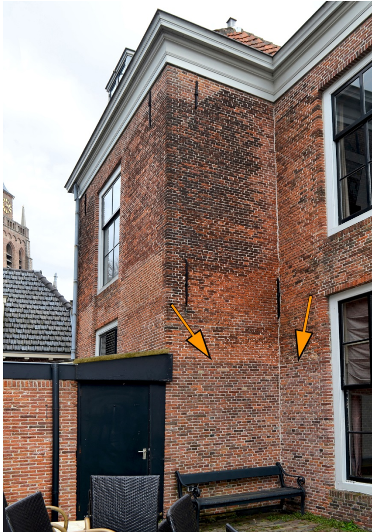
118. Baljuwhuis, achtergevel (noord) en westelijke zijgevel van de oostbeuk, met rechts nog net de westbeuk; de pijlen wijzen naar de overgang in het metselwerk, ontstaan in 1980-1982 door inboetwerk na de sloop van een privaataanbouw. Rechts nog net de berging uit 1982 en de overkapping van vóór 2012.
