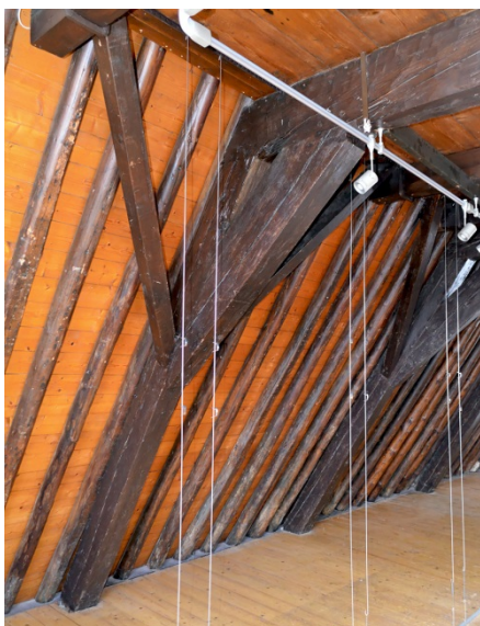
161. Ambachtshuis, zolder, het westelijke spantbeen van het zuidelijke jukspant (met telmerk '1') en zijn genagelde winschoren; geheel boven de strop van een hangbalk. 162. Ambachtshuis, zolder vanuit het zuidoosten, met zicht op de trap (1980-1982) aan de noordzijde naar de vliering en de hangbalken.
