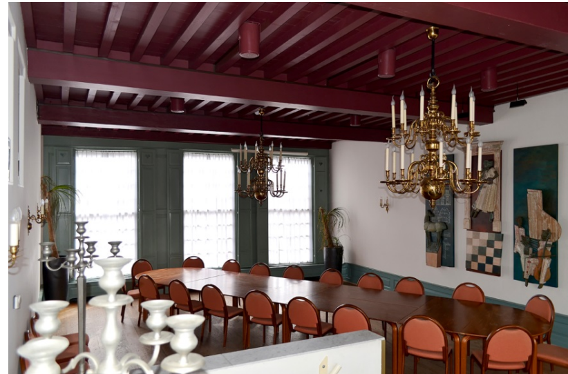
142. Ambachtshuis, bel-etage, zaal vanuit het noordoosten; de noordelijke (rechts) en zuidelijke moerbalk dateren van 1635-1640, terwijl de centrale moerbalk en de strijk balken zijn aangebracht, respectievelijk vervangen in 1980-1982.
