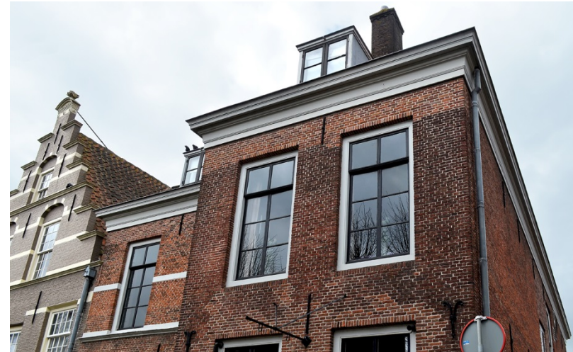
112. Baljuwhuis, voorgevel (zuid), bovenzijde van de oostbeuk van omstreeks 1740; het metselwerk onder de gevellijst (omstreeks 1740) is in 1980-1982 hersteld.
