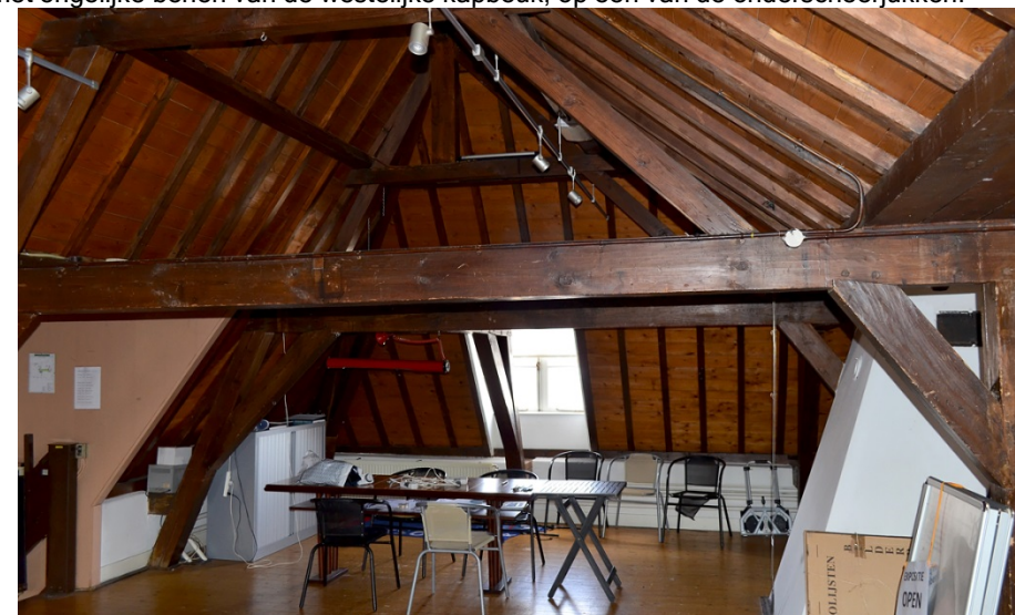
228. Baljuwhuis, zolder vanuit het zuidoosten; de standvinken onder de dekbalken van de onderscheerjucken, boven de scheidingsmuur tussen beide delen van het pand.
