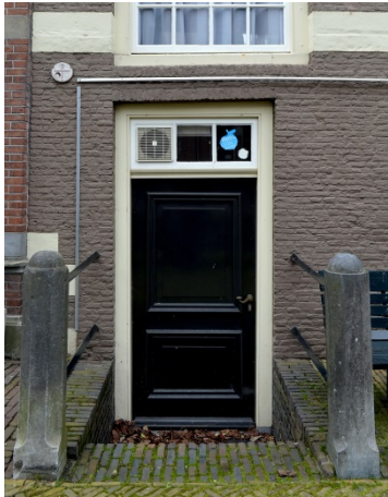
95. Ambachtshuis, voorgevel (zuid), de westelijke doorgang dateert waarschijnlijk van omstreeks 1810-1830, terwijl de deur is gekopieerd in 1980-1982, toe ook het bovenraam is aangebracht.
