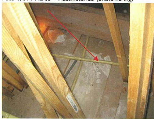
Foto 6, 02 / Als ML 03 – Restanten plaatmateriaal
