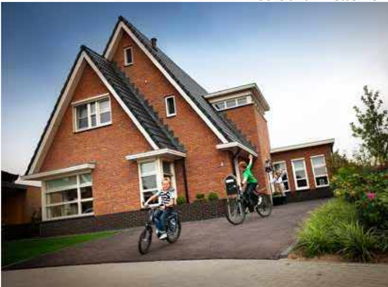
Gevels van metselwerk
