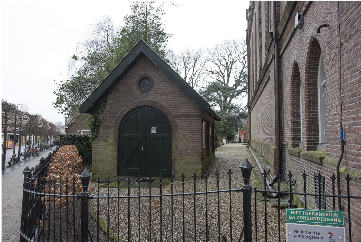
Figuur 7 Eeuwenlang werd in of nabij de kerk begraven. Onderdeel van de begraafplaats was een baarhuisje waar de doden werden opgebaard. Dit baarhuisje kwam tegelijkertijd met de bouw van de nieuwe kerk in 1868 naar ontwerp van Adolphus Druiding (1838-1900) tot stand. Alhoewel inmiddels buiten gebruik heeft het gebouwtje door zijn architectuur en ligging een onlosmakelijk relatie met de geschiedenis van de kerk.
