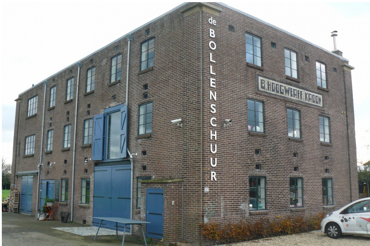
Figuur 35 De uit baksteen opgetrokken bollenschuur van Hoogwerff Kroon werd in 1928 gebouwd met een mechanisch ventilatiesysteem om de bollen te drogen ( www.bollenerfgoed.nl ).
