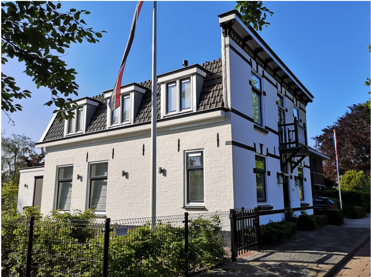
Figuur 36 Met behoud van de karakteristieke hoofdvorm en detaillering kreeg Veurseweg 76 een tweede leven (foto 2021).
