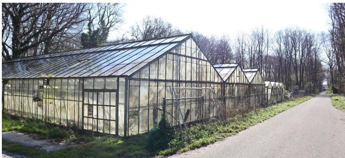
Fig. 4. Aanzicht kassencomplex Laan van Pluymestein
