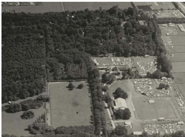
28. De boerderij Het Uilennest met omgeving omstreeks 1937. De boerderij is rechts van het midden zichtbaar. De boerderij wordt in 1942 gesloopt om plaats te maken voor de SS-kazerne. Links is het beboste gebied zichtbaar, waar de bunker zou worden gebouwd. (Herkomst: beeldbank Haags gemeentearchief identif.,nr. HGA 1901549)
