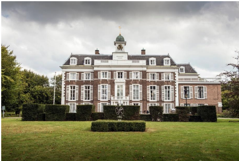
24. Het in opzet 17de-eeuwse landhuis Clingendael was het woonhuis van Seyss-Inquart in Den Haag. Zijn kantoor had hij in het centrum van Den Haag. (Herkomst: Beeldbank RCE documentnummer 14133-58243)
