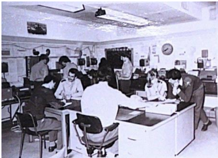
107. Telexruimte, ruimte 024 en 024A. Beide ruimtes waren hier nog samengevoegd als één ruimte. Jaartal onbekend, maar waarschijnlijk omstreeks 1980. (Herkomst: Historisch Collectie Verbindingsdienst, Amersfoort)
