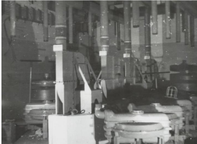
79. Ruimte 020 met de Duitse luchtzuiveringsinstallatie, gezien richting de noordoosthoek van deze ruimte. Op deze afbeelding is te zien dat de luchtinlaatbuis (noordoosthoek van de machinekamer) tijdens de Tweede Wereldoorlog op dezelfde locatie zat als tijdens de Koude Oorlog. Foto 1947
