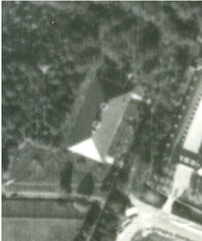
68. Luchtfoto uit 1944 met daarop duidelijk herkenbaar de beide opritten naar de ruimten naast de bunker. De loopgraaf wordt, met uitzondering van de zuidzijde door beplanting aan het zicht onttrokken. Parallel langs de sloot aan de westzijde is een (voet)pad zichtbaar. Het noorden bevindt zich aan de linkerzijde. (Herkomst: beeldbank Haags gemeentearchief identif.,nr. 5.20332)
