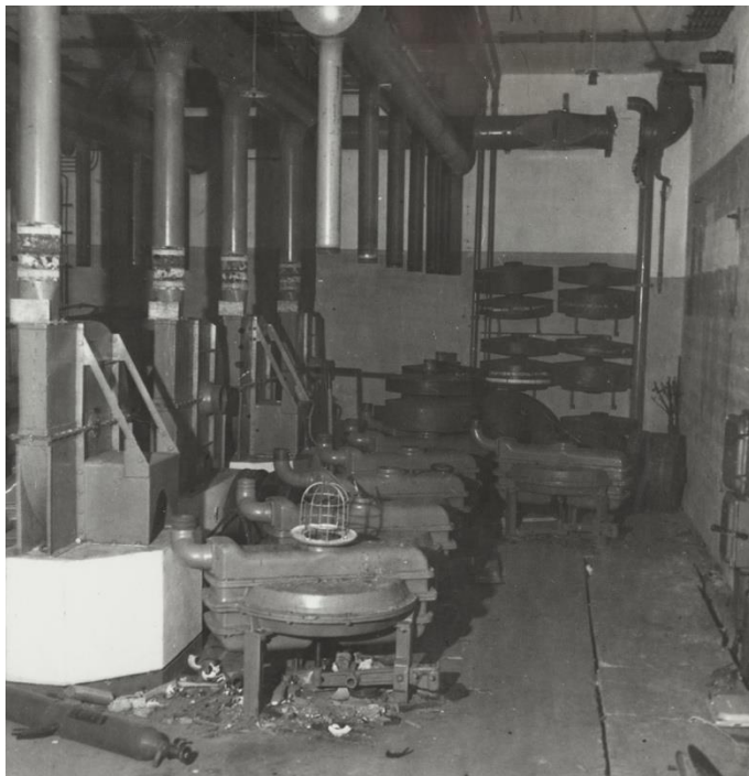
115. Ruimte 020 met de Duitse luchtzuiveringsinstallatie. Foto 1947. (Herkomst: beeldbank NIMH, objectnummer 2155_003713)
