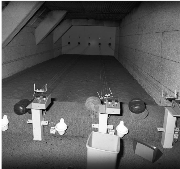
92. Schietbaan op de eerste verdieping aan de noordzijde van de bunker (ruimte 162C). De draagbalken van het bunkerdak zijn zichtbaar. De rest van de wandbekleding en het plafond is erin geplaatst ter aankleding van de ruimte en als geluidsisolatie. Foto 1991. (Herkomst: beeldbank NIMH, objectnummer 2001_91-2-02-1815-C15)
