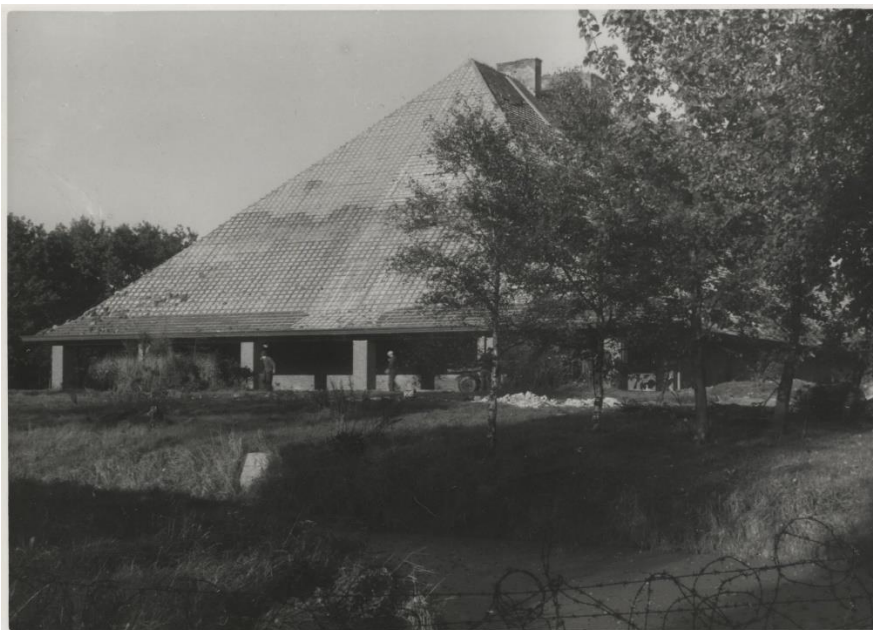
65. Zicht op de westzijde van de bunker. Aangezien het dak hier al geheel is ontdaan van dakpannen zal deze foto gemaakt zijn na de vorige foto's. Op de voorgrond is één van de funderingsblokken zichtbaar vanwaar een zendmast was afgespannen. Foto 1945. (Herkomst: Beeldbank Haags Gemeentearchief. identif.nr. 6.15722).
