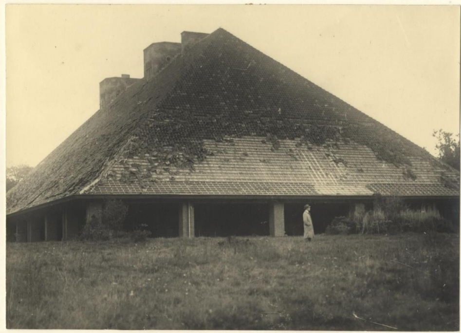
58. Foto van vlak na WOII, zicht op de noordwestzijde van de bunker. Op het dak is het grootste gedeelte van de dakpannen van het romaanse type nog aanwezig. Het gemêleerde karakter is goed herkenbaar. Ook is de camouflageschildering op de observatiepost en schoorsteen goed herkenbaar. (Herkomst: Beeldbank Haags Gemeentearchief. identif.nr. 0.80955).
