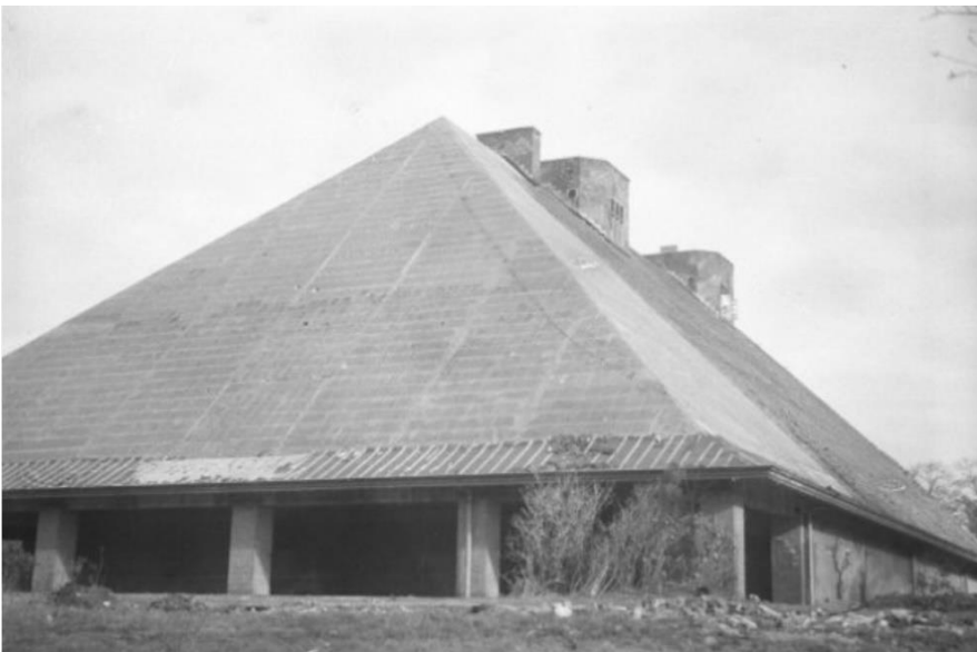
67. Het gebouw gezien vanuit het westen. Het open karakter van de gevels verhuult de massieve constructie van de bunker zelf. Foto 1947 (Herkomst: Beeldbank NIMH, objectnummer 2001_7-47-01).
