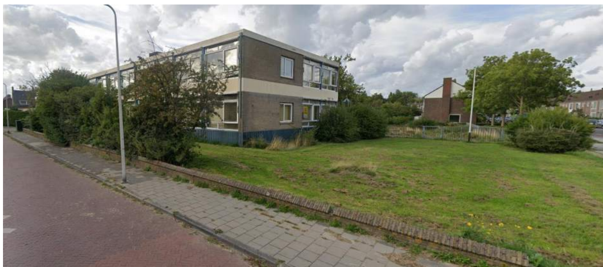
Afbeelding 2: Bebouwing huidige situatie, gezien vanaf de Lord Baden Powellweg
