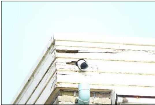
Figuur 9: Kapotte houten dakrand met regenpijp dwars er doorheen.
