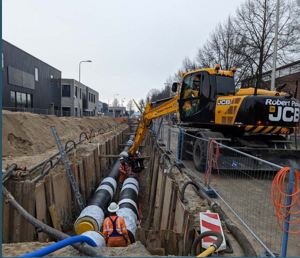
Aanleg van een transportnet
