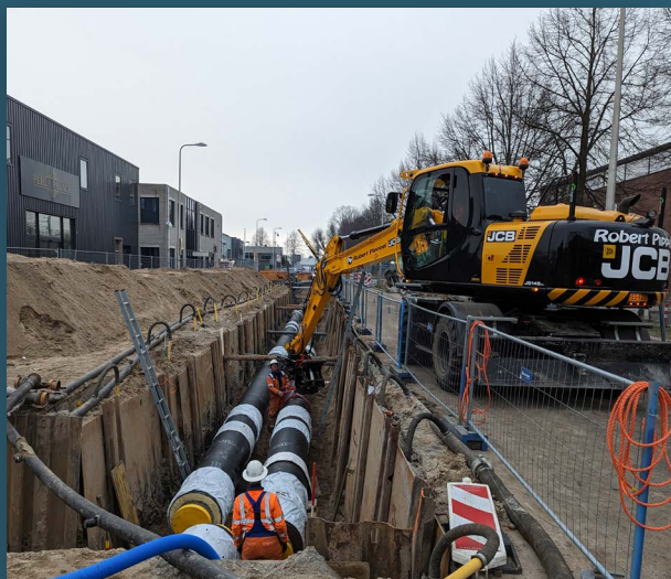
Aanleg van een transportnet
