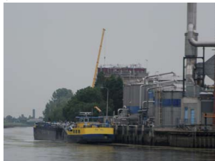
Damwanden als oevers dienen alleen te worden toegepast bij bedrijven op de zellingen die aan- en afvoeren per schip.
