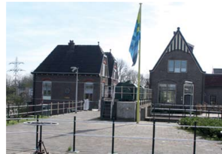
De Waaiersluis vormt een cruciale oversteekplaats voor langzaamverkeer in het stroombed van de IJssel. Een opwaardering van de huidige overgang is een welkome aanvulling op het recreatieve routenetwerk.
