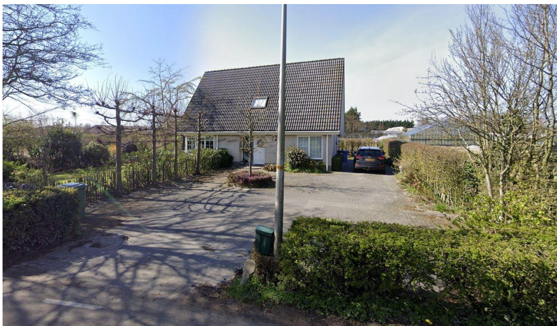
Impressie voorzijde woning, gezien vanaf de Oostdorperweg (bron: Google Streetview)
