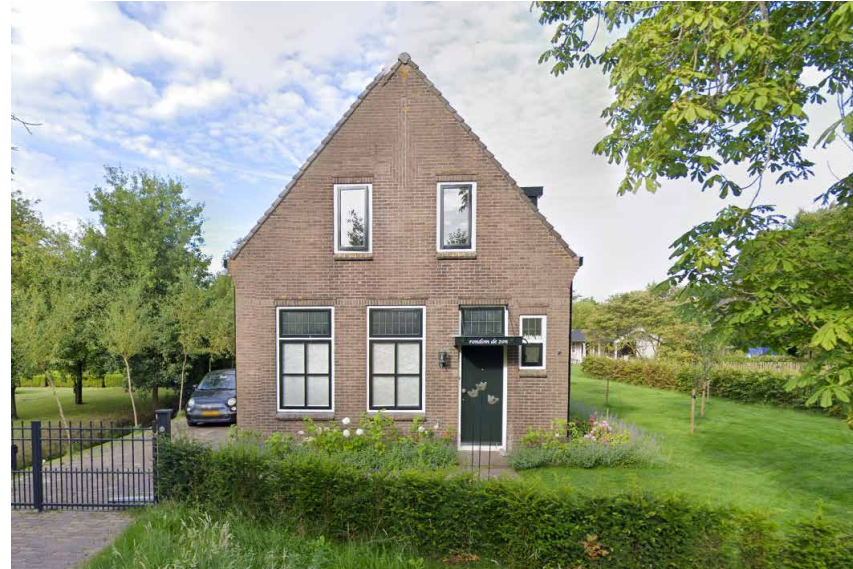
Figuur 14: Bestaande karakteristieke historische woning (nr. 41) (Bron: Google Streetview)
