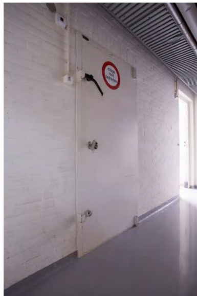
Kluisdeur in de kelder. Eén van de weinige oorspronkelijke elementen in het kantoor.
