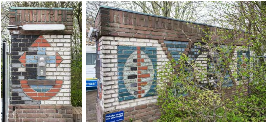
Siermetselwerk met links weinig fraai toegevoegde bel en brievenbus. Aan de binnen- en buitenzijde zijn onder andere dag en nacht verbeeld.
