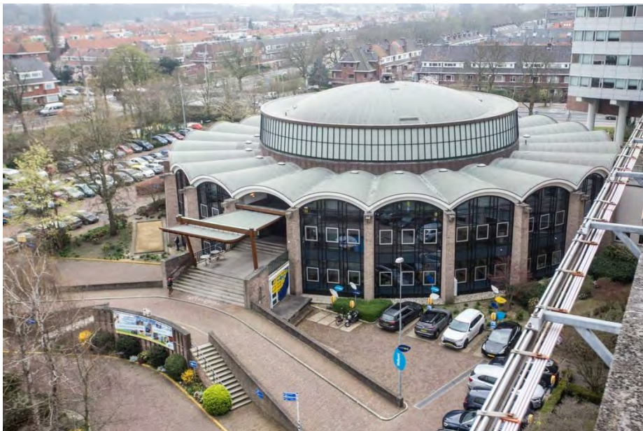
De rotonde vanaf het dak van het kantoorgebouw gezien.
