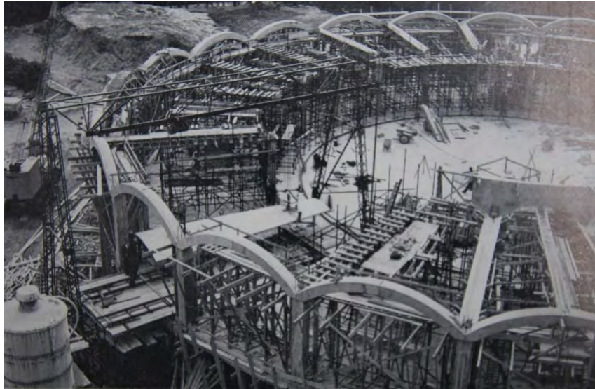
Buitenringconstructie nadert voltooiing.
