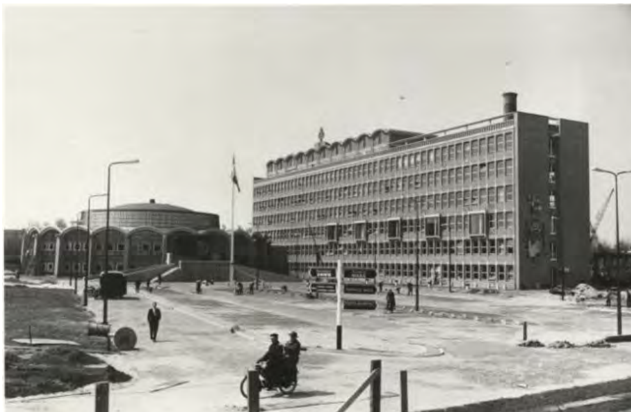
Parkeerterrein in aanleg. Vlaggenmast zonder fietsenluifel en de lantaarnpalen van de firma Bronswerk al opgericht. Prominent bij inrijden een grote wegwijzer van de ANWB.
