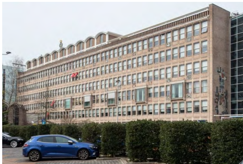
De voorgevel van het pand in huidige toestand. Vernieuwing van de vensters met behoud van oorspronkelijke vensterindeling is de voornaamste aanpassing. De rail voor de glazenwasser dateert ook niet uit de bouwtijd.
