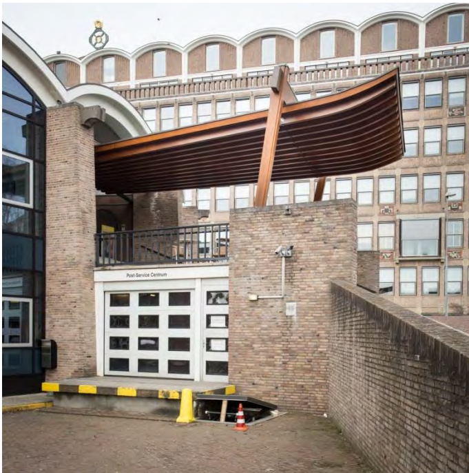
Oorspronkelijk konden leveranciers onder de luifel en loopbrug doorrijden. In die tijd waren de vrachtwagens (en de ladingen) over het algemeen nog wat kleiner.
