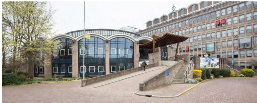
Rotonde met daarachter de kantoorshoofdingang. Er is sprake van vier verkeersbanen, links voor de auto's van leveranciers, de opgang met trottoirs voor automobilisten die inzittenden af willen zetten voor de hoofdingang, de trap voor bezoekers die met de fiets of het openbaar vervoer zijn gekomen en geheel rechts de buitenlus van de parkeerplaats.
