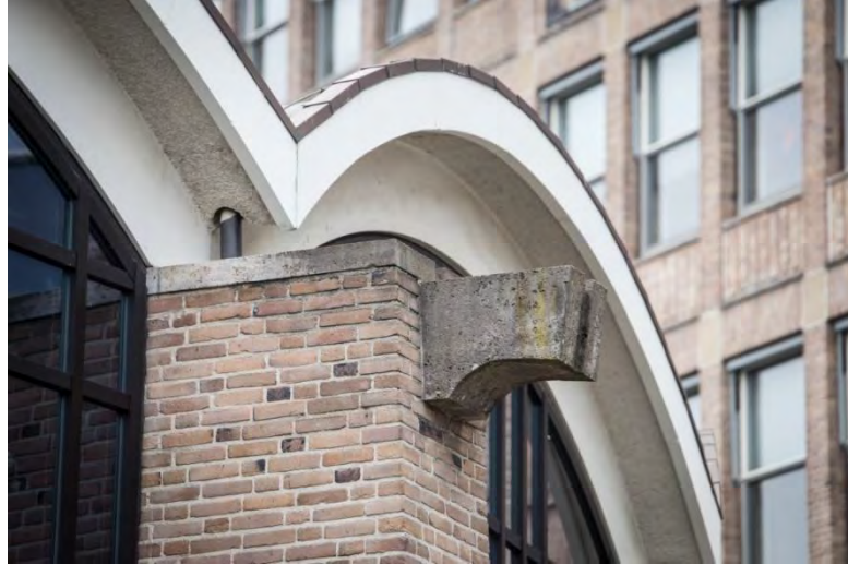
Detail van het exterieur van de rotonde.
