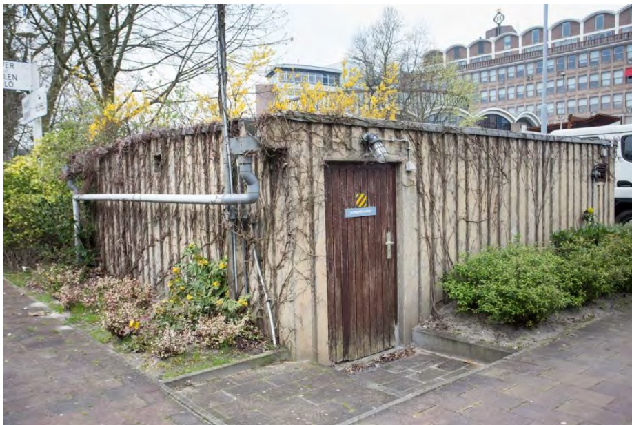
Het pompegebouw dat aanvankelijk aan de waterkant stond maar door gedeeltelijke aanplanting van de vijver nu tussen tuin en parkeerplaatsuitbreiding te vinden is.
