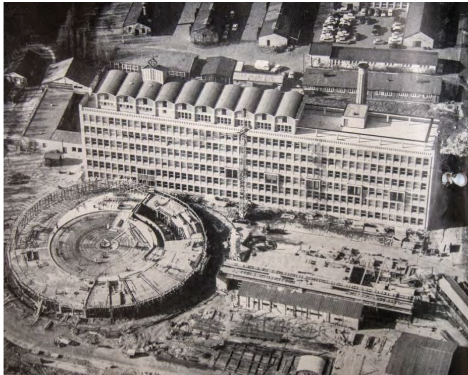
Constructie van de begane grond van de rotonde bijna voltooid.
