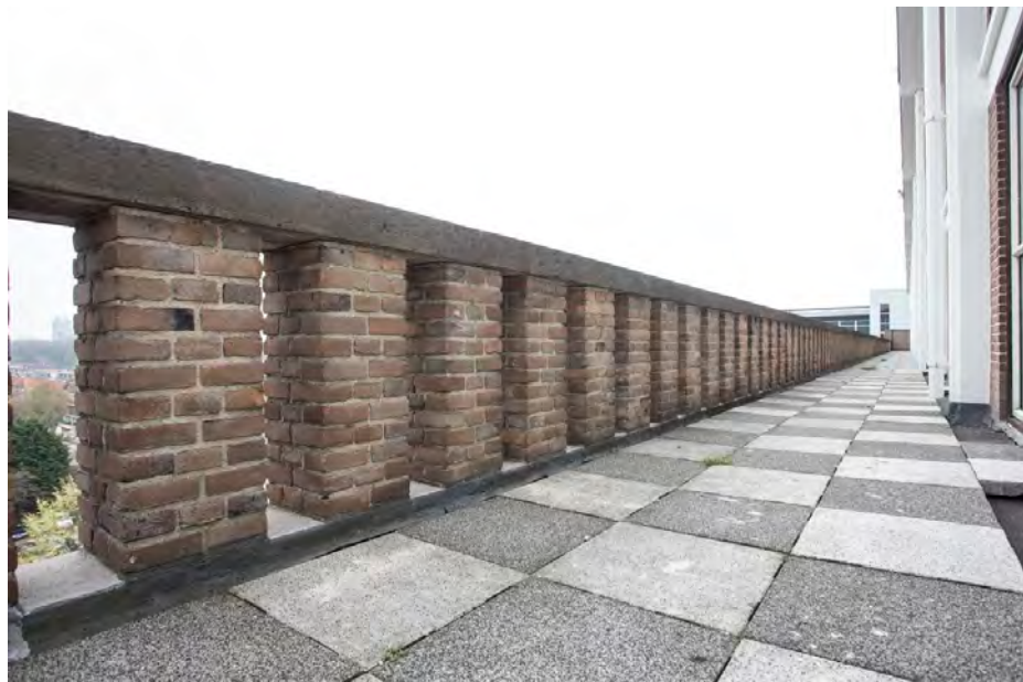
De balustrade op de dakrand.
