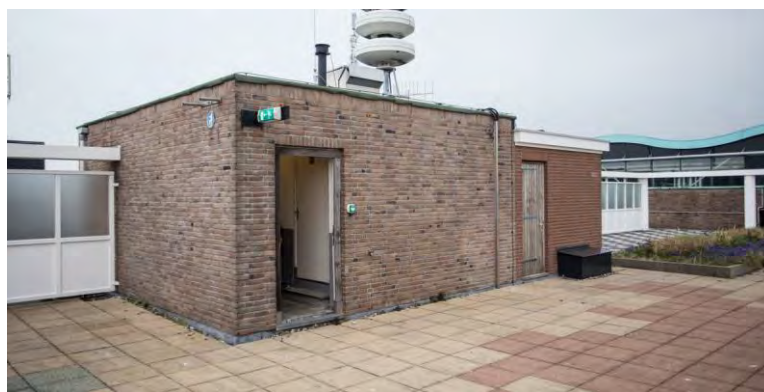
Oorspronkelijke (l) en secundaire opbouw op het dak. Hierachter stond de schoorsteen.
