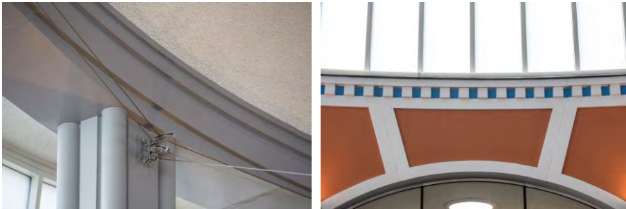
Aansluiting van de kolommen die met profielstukken zijn afgetimmerd op de ringbalk. Rechts de elementen die door de architect timpanen werden genoemd.
