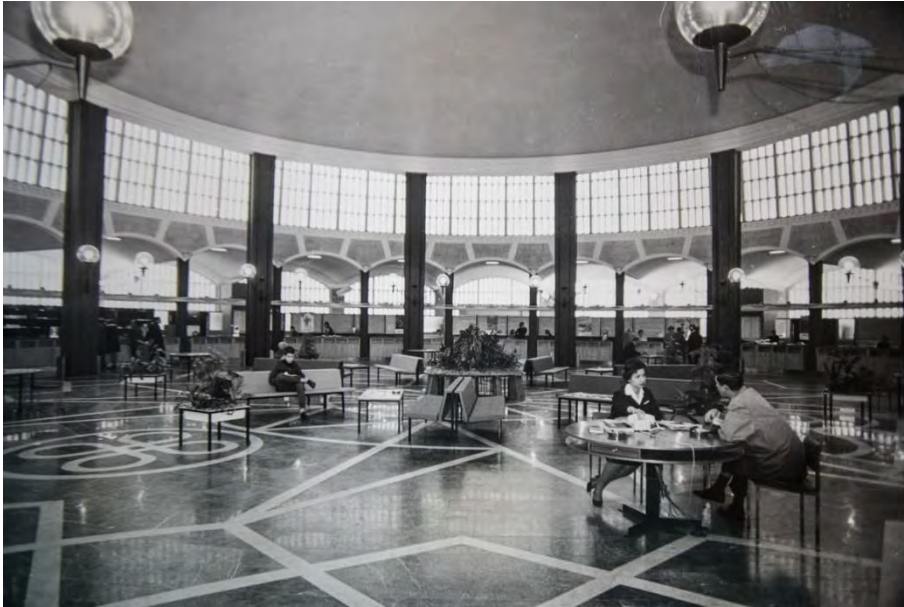
Opname kort na de voltooiing van het werk, met goed zicht op de kolomconstructie, de ringbalk, de koepel en in de achtergrond de schaaldaken van de zijbeuk.
