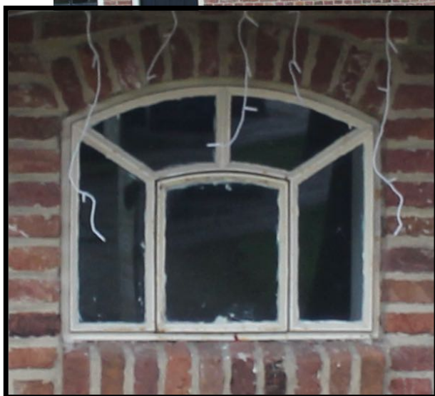
26-27. De eerste uitkubbing is koud tegen de muur van het voorhuis gezet. Het gietijzeren stalraampje kan geopend worden.
