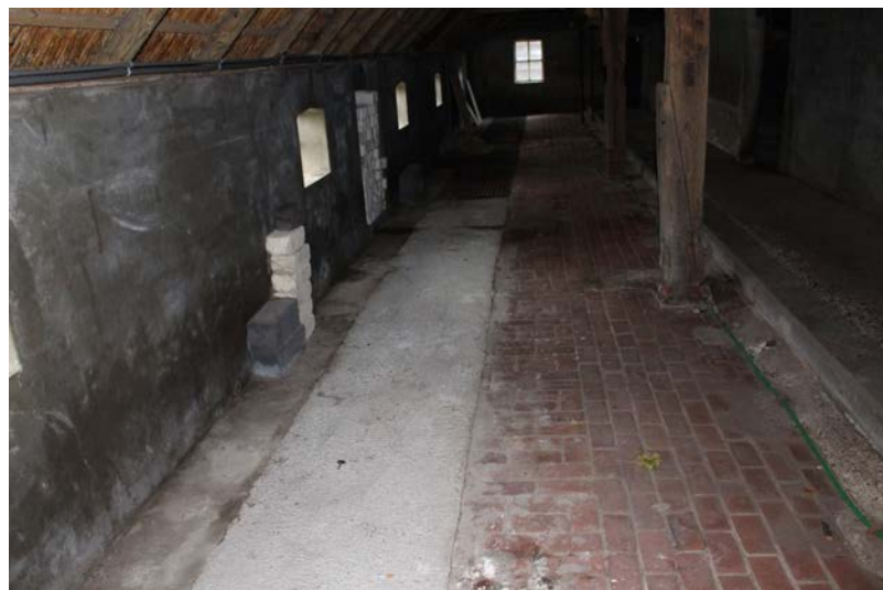
64-66. De kapconstructie bestaat uit daksporen van bekap rondhout, haanhouten en een nokbalk. Er zijn windverbanden. De vloeren zijn bestraat of van beton. De functie is soms nog te zien: een grup en een voergoot.
