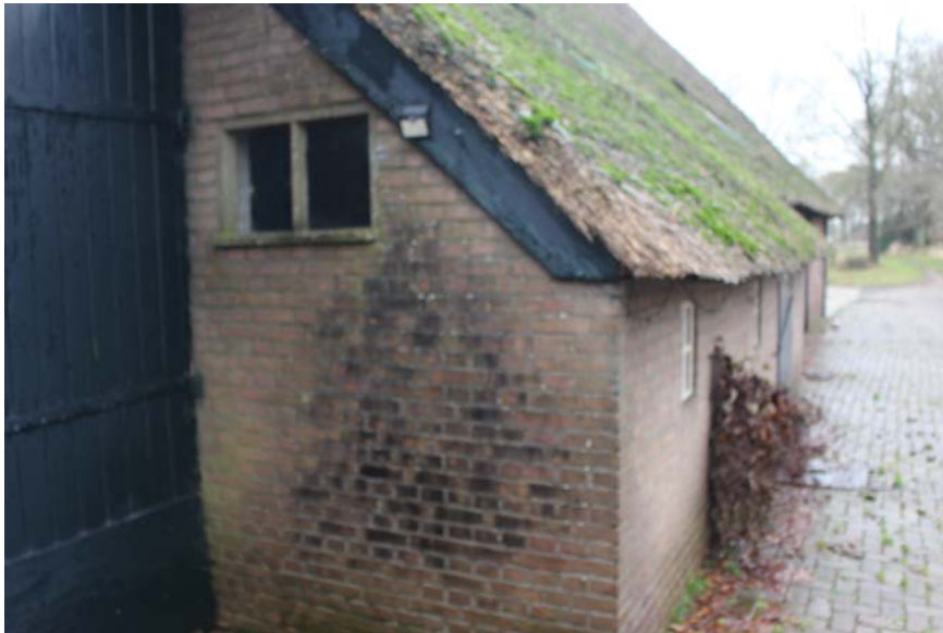
31-32. De eerste uitkubbing heeft een gietijzeren stalraam, de tweede heeft een betonnen stalraam in de onderschoer.
