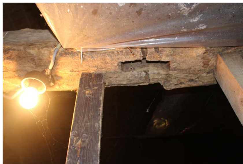
69-70. Ankerbalk van gebint 9 (met telmerk 10) waarin de schoor en een stijl weggehaald zijn, maar die waarschijnlijk het eind van de boerderij uit 1832 aangeven.
