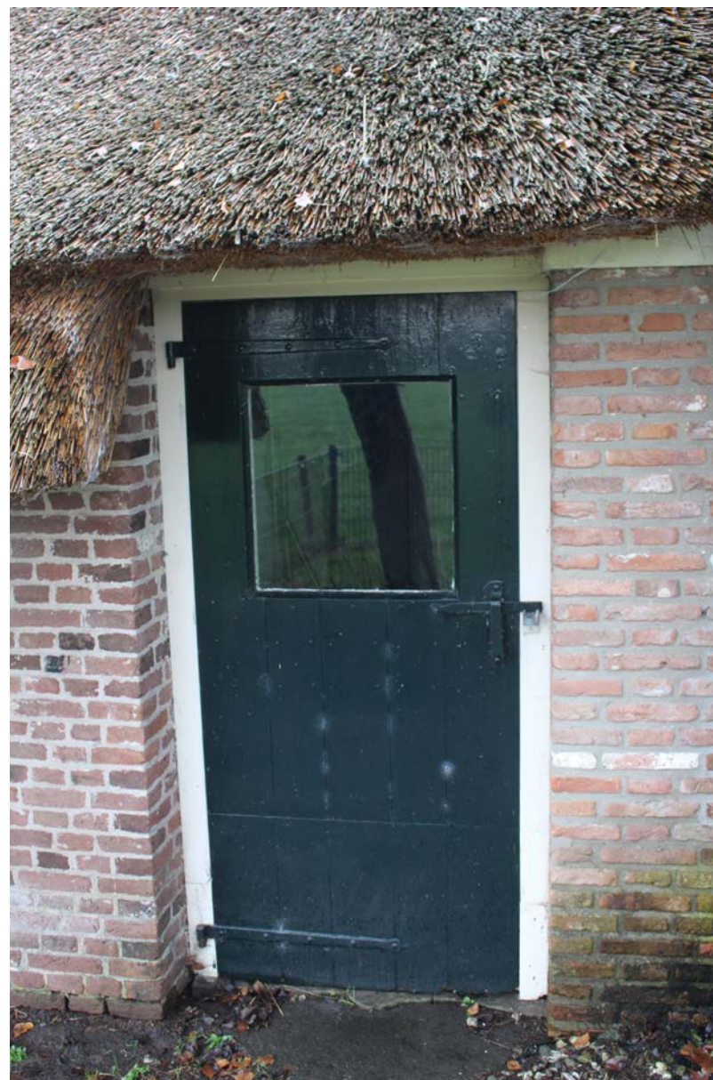
12. De deur voor de bijkeuken 1.5. Net als de andere deuren in deze zijgevel is hij opgeklampt. Hij is vernieuwd. De gehengen zijn oud.
