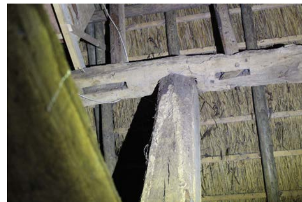
71-73. Voor de gebintplaten is veelvuldig gebruik gemaakt van hergebruikte balken.
