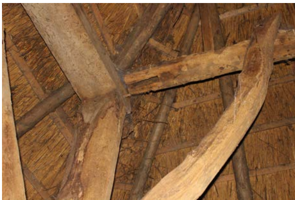
71-73. Voor de gebintplaten is veelvuldig gebruik gemaakt van hergebruikte balken.
