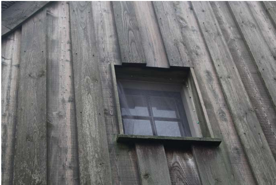
6. De top is verticaal gepotdekseld. De vensters in de top zijn nu verdiept door de betimmering.
