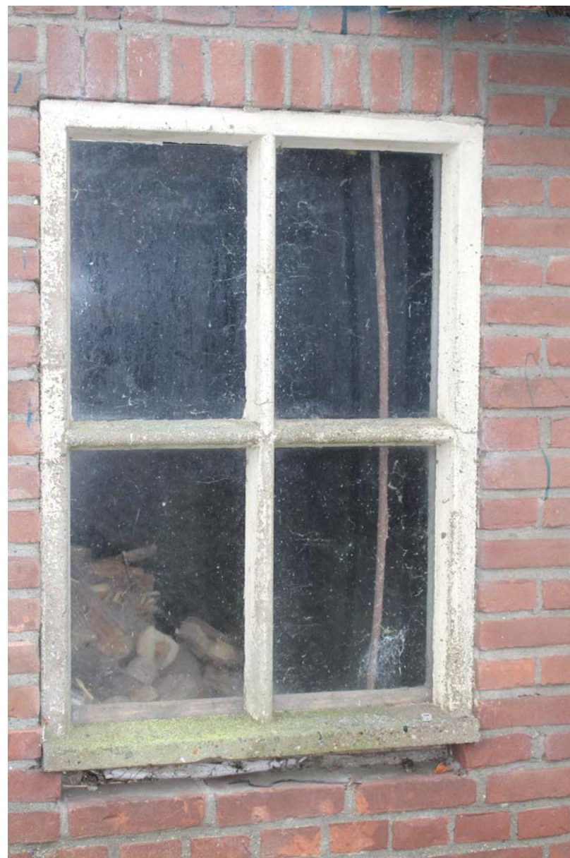
21-22. De vensters hebben betonnen stalramen van verschillend formaat. Ze hebben alleen aan de bovenzijde een rollaag.
