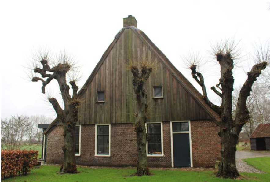
1. De voorgevel. De top is betimmerd.
