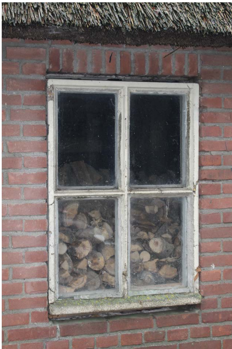
21-22. De vensters hebben betonnen stalramen van verschillend formaat. Ze hebben alleen aan de bovenzijde een rollaag.
