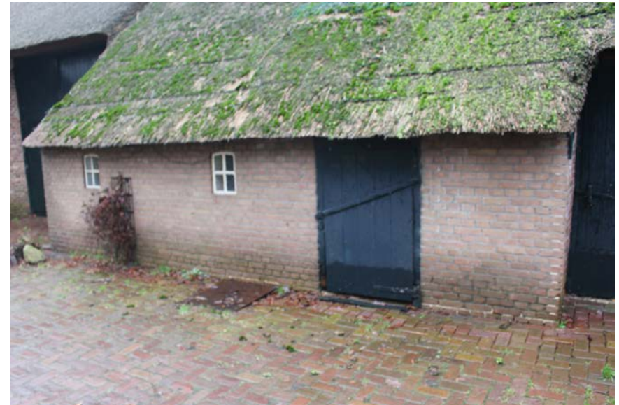
33-34. De tweede uitkubbing heeft twee gietijzeren stalraampjes. De deur heeft een sluiting aan de buitenkant als van een luik.
