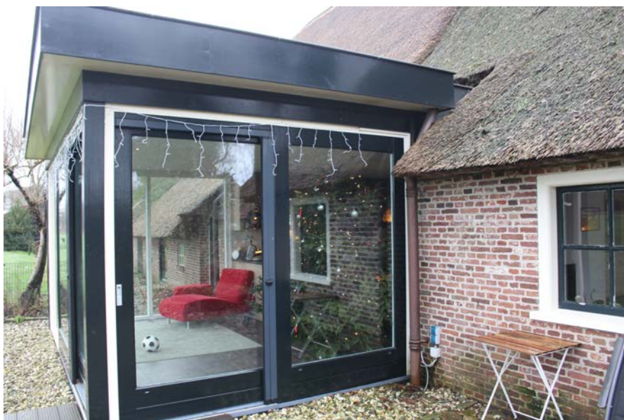
11. De serre, die bij de verbouwing van 2012 is aangebracht.
