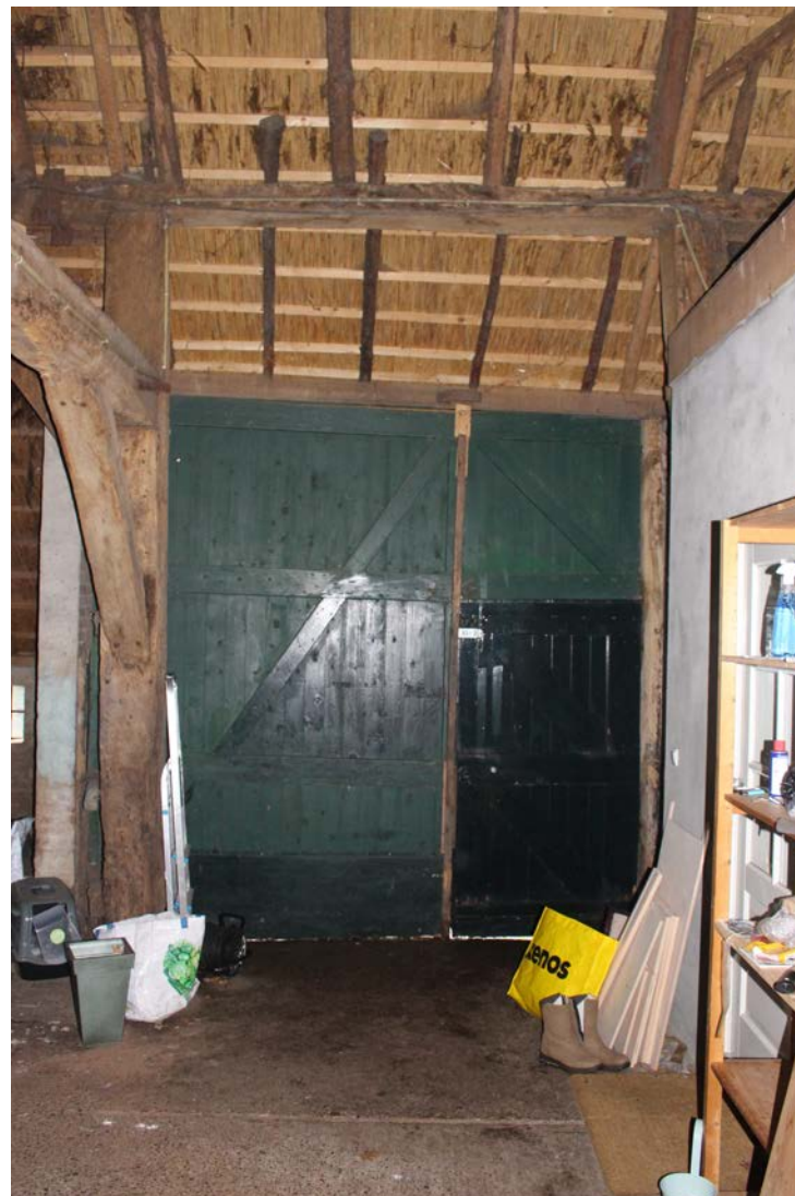
64-66. De kapconstructie bestaat uit daksporen van bekap rondhout, haanhouten en een nokbalk. Er zijn windverbanden. De vloeren zijn bestraat of van beton. De functie is soms nog te zien: een grup en een voergoot.
