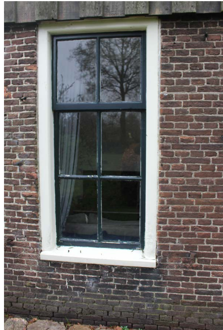
2. Het linker venster is aan de rechterzijde ingebroken. Het vensterkozijn is geprofileerd met een duivejager. De ramen zijn schuiframes.
