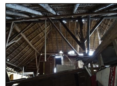
Figuur 10. Binnenzijde schuur op noordelijk deel van de onderzoekslocatie.
